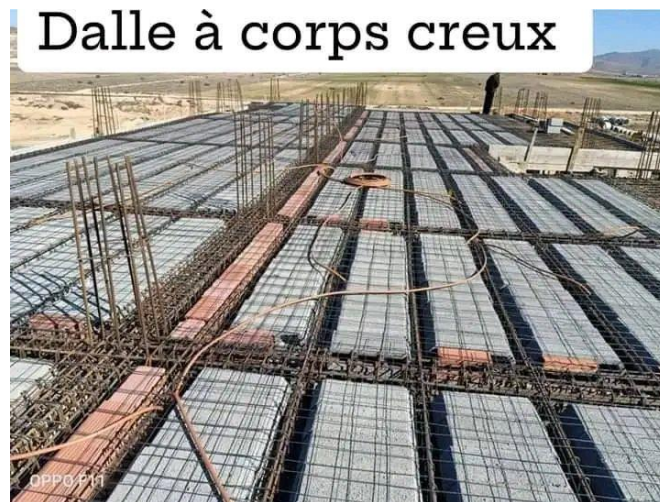
Figure I.2 : Plancher en corps creux [3]
