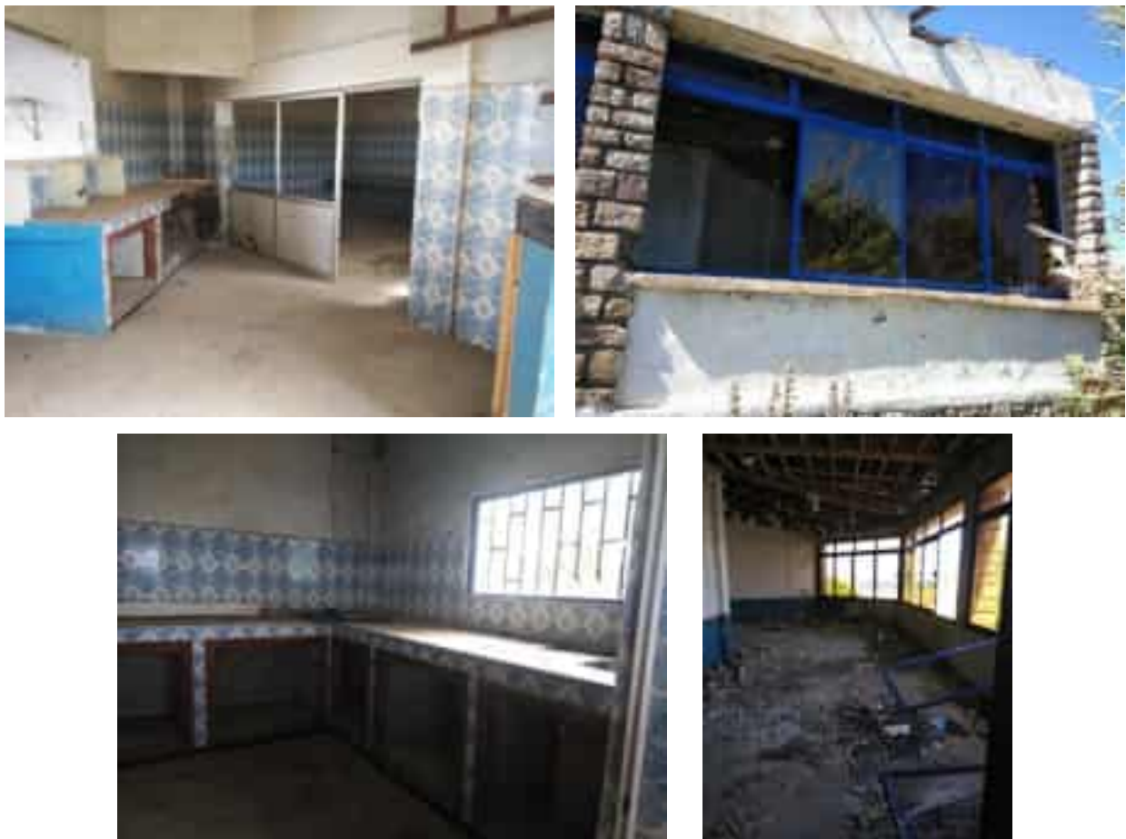
Figure 40 : L'intérieur de la construction,
