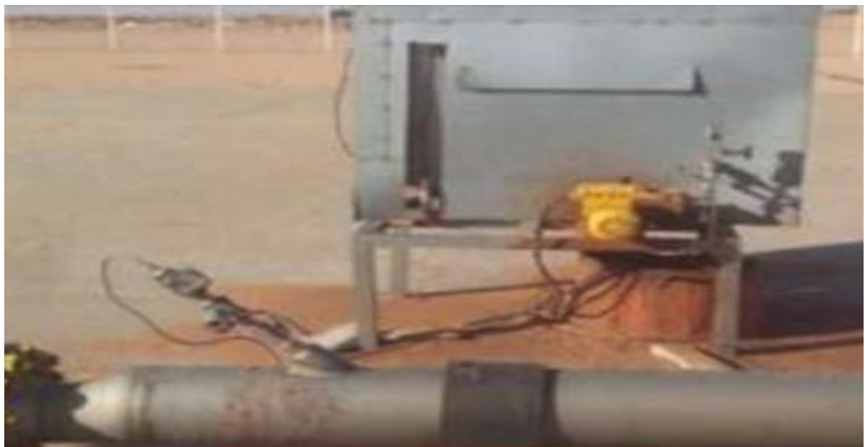
Figure 4. Pompe doseuse responsable à injecter l'inhibiteur de corrosion.
