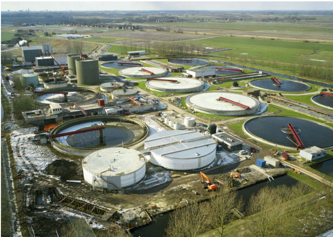
FIG. 1.1 – Station d'épuration de Garmerwolde (Pays-Bas)
