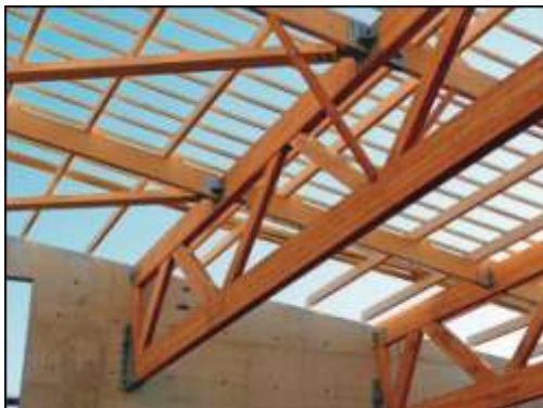
Figure 109 : des poutres en lamellé collé
