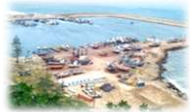
Figure 76 : le port de Béni Saf (source Google image)
