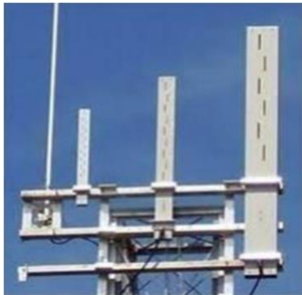
Figure I.10. Exemple d'une antenne à fentes [13]
