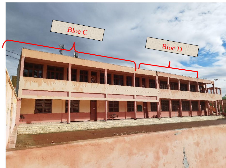
Figure 4. 5 : vue d'ensemble des blocs pédagogiques C et D réalisés en béton [43]
