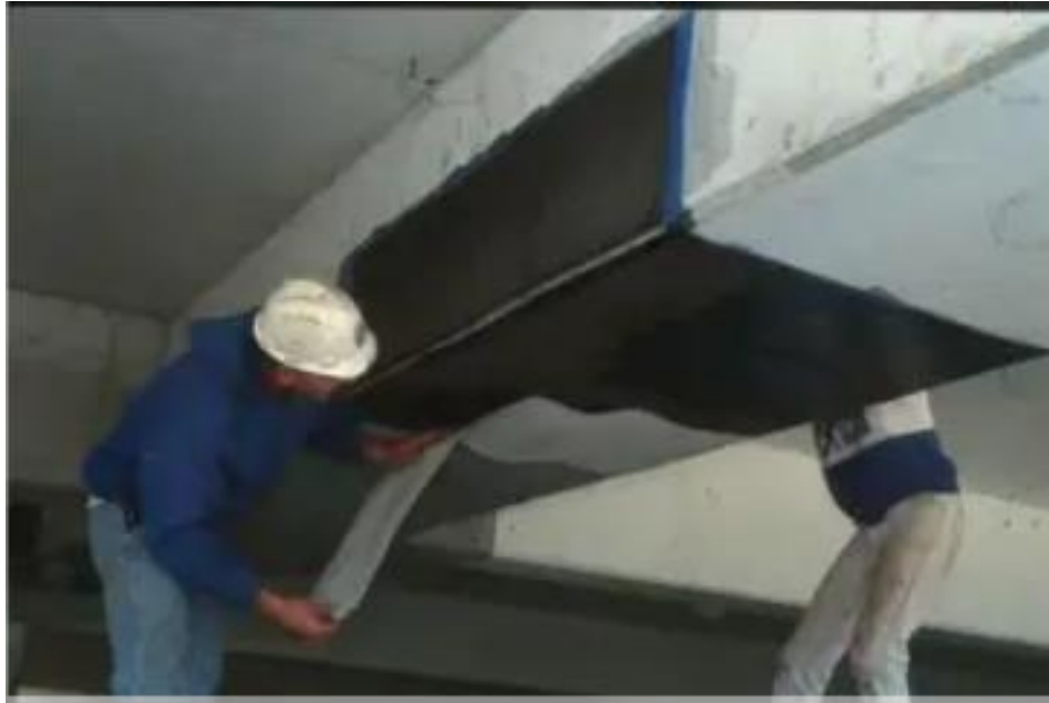
Figure 3. 24: renforcement d'une structure en béton par feuille de fibres de carbone [15]
