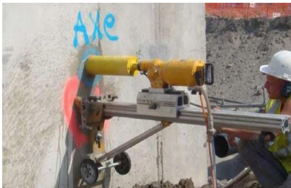
Figure 3. 10: carottage du béton armé [12]
