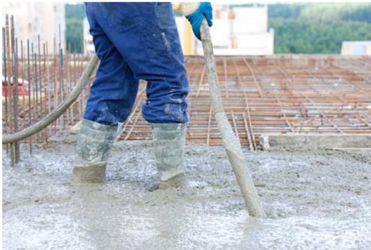
Figure 1. 10 : vibration du Béton [38]
