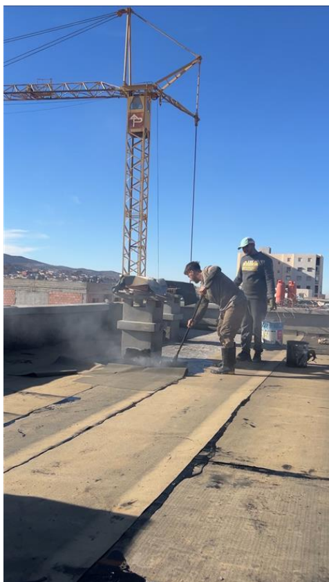
Figure 3. 12: mise en œuvre d'une membrane bitumineuse d'étanchéité [36]
