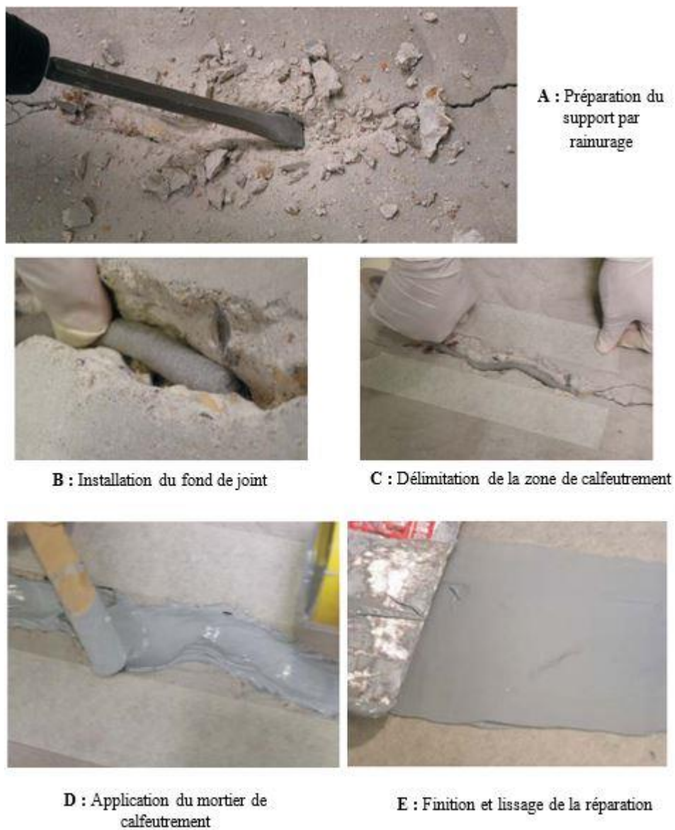
Figure 3. 17: mise en œuvre du calfeutrement [17]
