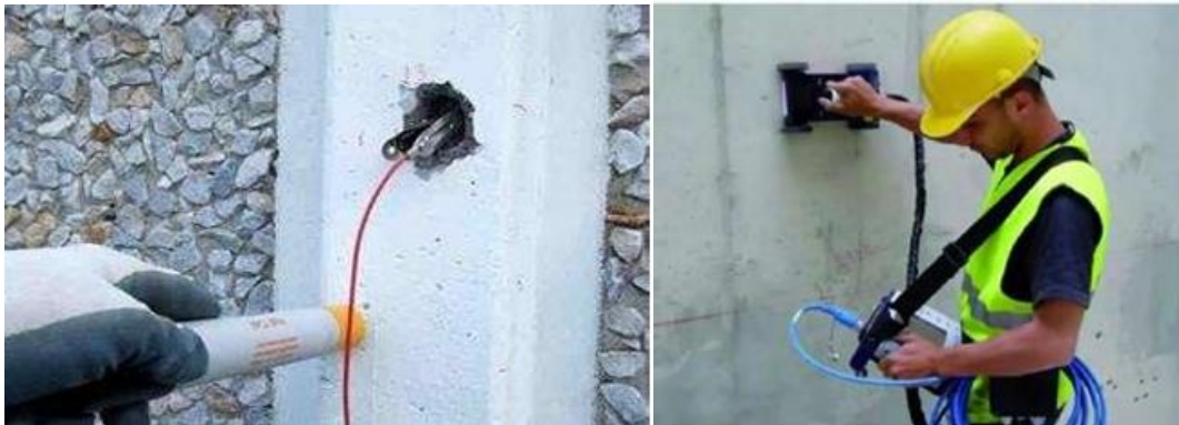
Figure 3. 7: mesure du potentiel de corrosion [12]
