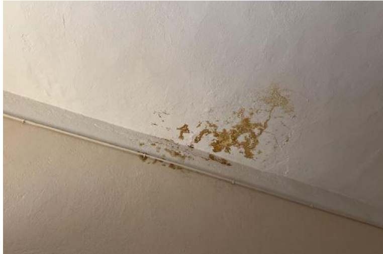
Figure 4. 6 : indices de corrosion des armatures dans la partie 1 de bloc A [43]
