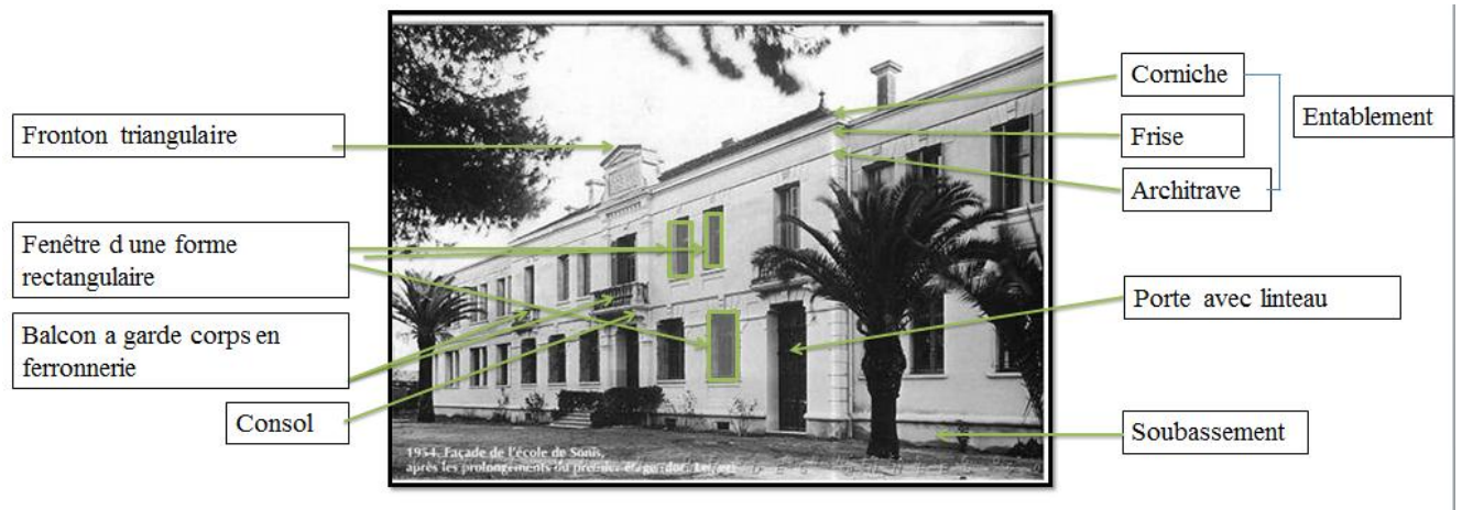
Figure 37 . Façade principale de l'école Sonis
