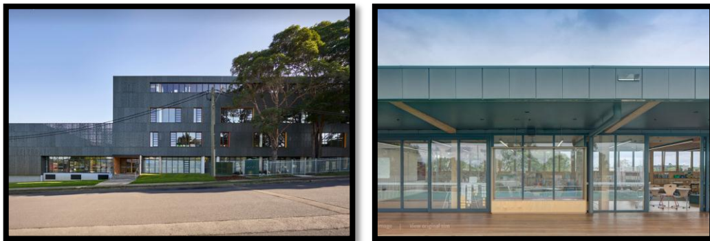
Figure 25 . Photos de l'école
