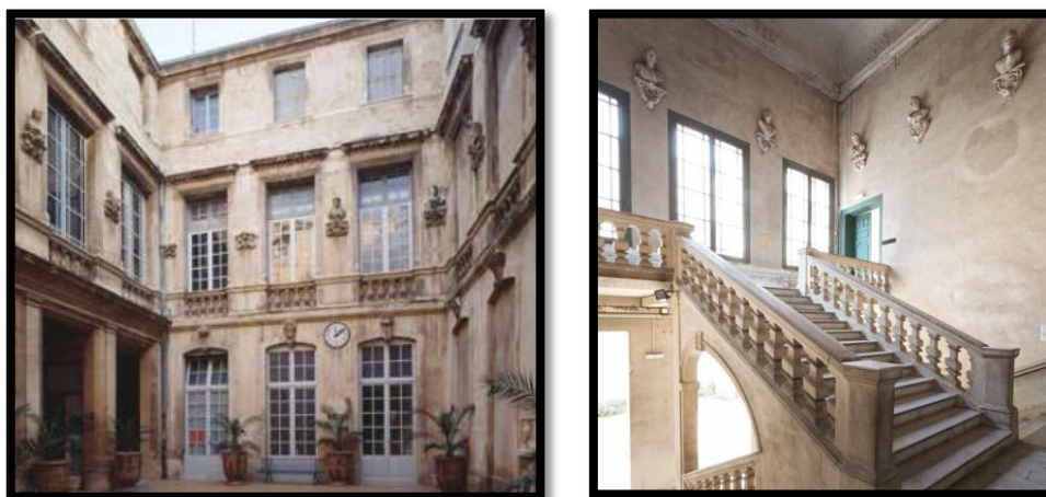
Figure 31 . La cour, état au début des années 1990 et La cage d'escalier avant restauration.
