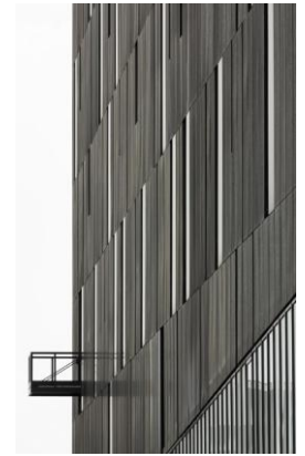
Figure 83: traitement de la façade
