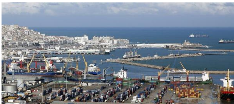
Figure 5 le grand port d'Alger
