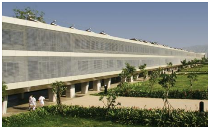
Figure 46: la façade sud de l'hébergement
