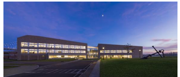
Figure 62: la façade sud dans la nuit
