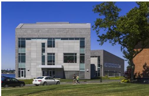
Figure 61: la façade est du centre
