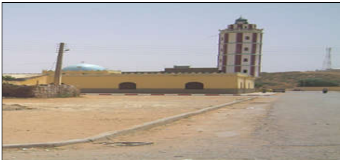
Figure II.7 : Mosquée situer dans le site de projet [10]
