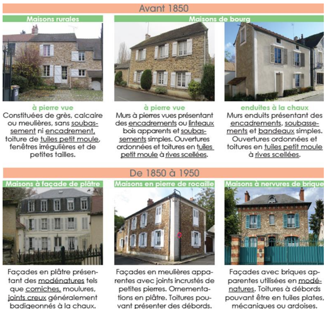
Figure I.7: Typologies du bâti ancien
