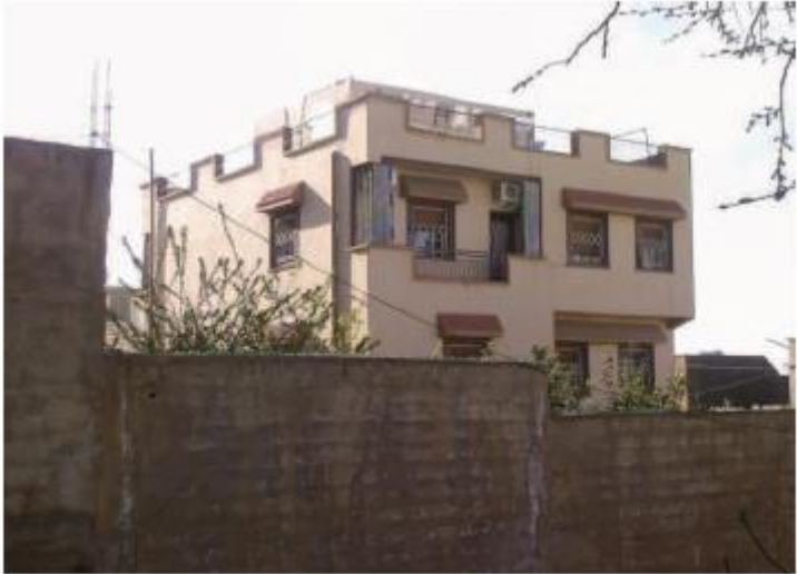
Figure IV.44: La maison étudiée (Vue Sud – Sud Est) [42]
