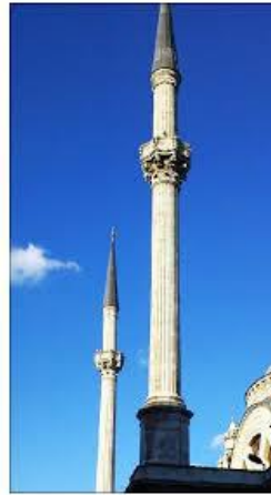
Figure 3.2 : Les deux minarets de la mosquée Dolmabahçe. (Houmat & Seghir, 2019)
