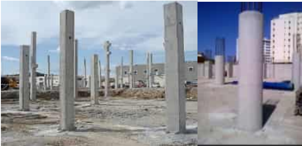
Figure 90 : poteaux en béton armé. Source : 1 elements_deconstruction_sefetc.pdf (mcours.net)
