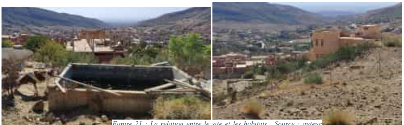
Figure 21 : La relation entre le site et les habitats . Source : auteur 11/08/2023
