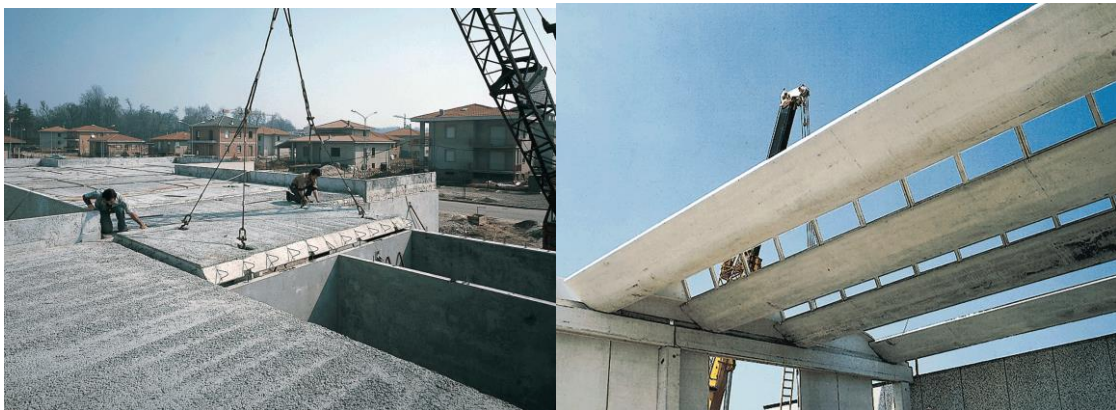
Figure 7 : des éléments préfabriqués béton léger /structure, ossature
