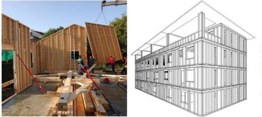
-Figure 10: ossature en bois
