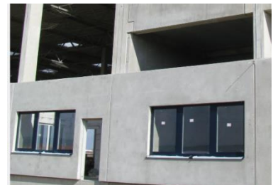
-Figure 74 : mur en béton préfabriqué.
