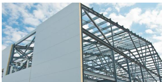
-Figure 70 : la structure métallique
