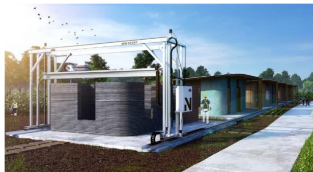
Figure 2 : Une imprimante 3D qui construit une maison
