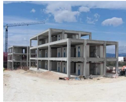
-Figure18 : Portique en beton
