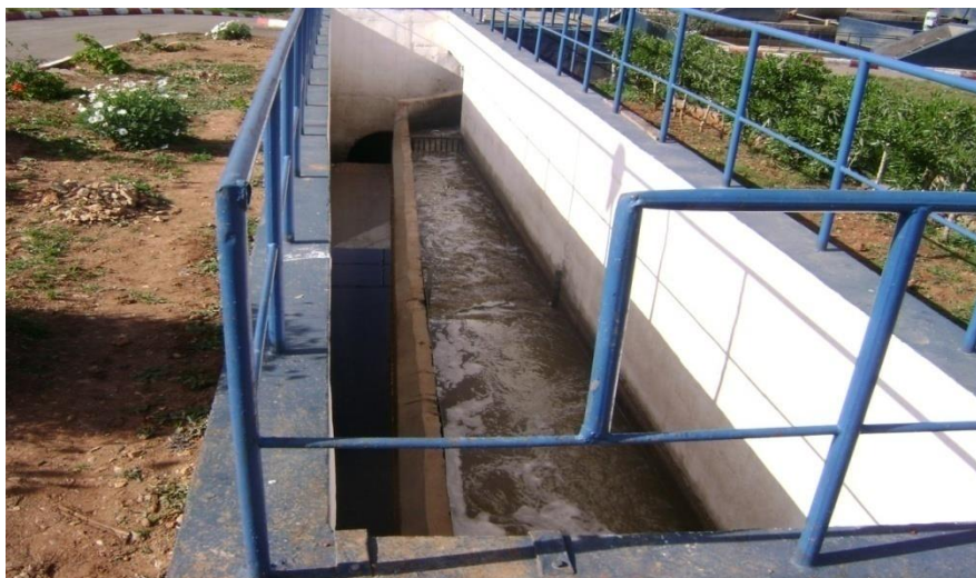
Figure 24: Déversoir d'orage
