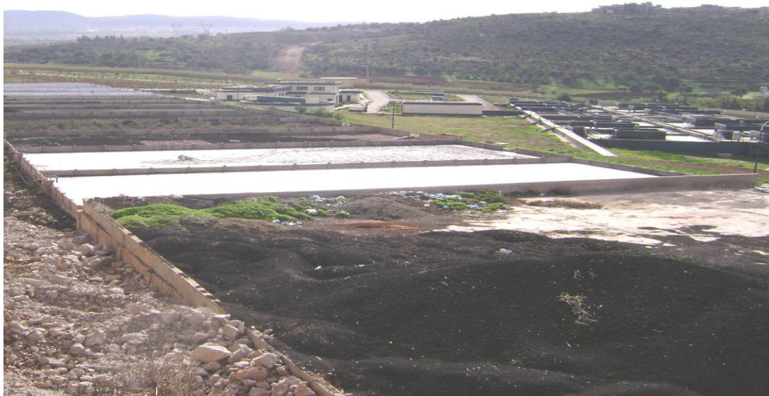
Figure 33: Lits de séchage + Aire de stockage
