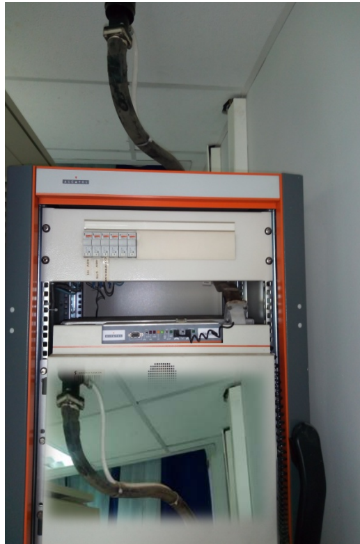
Figure I. 6. Un guide rectangulaire prise au niveau de Sonalgaz (Imama_Tlemcen).
