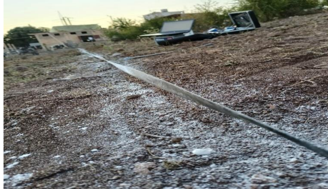
Figure 63 : Ligne droite pour installer les électrodes
