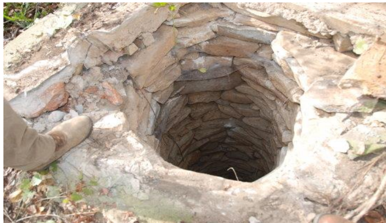
Figure 27 : Puits creusé à la main
