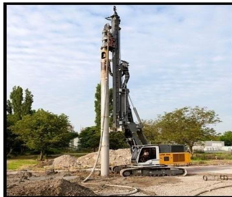
Figure 33 : Forage par havage
