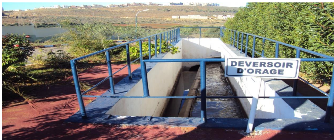
Figure IV. 2: Déversoir d'orage [53].
