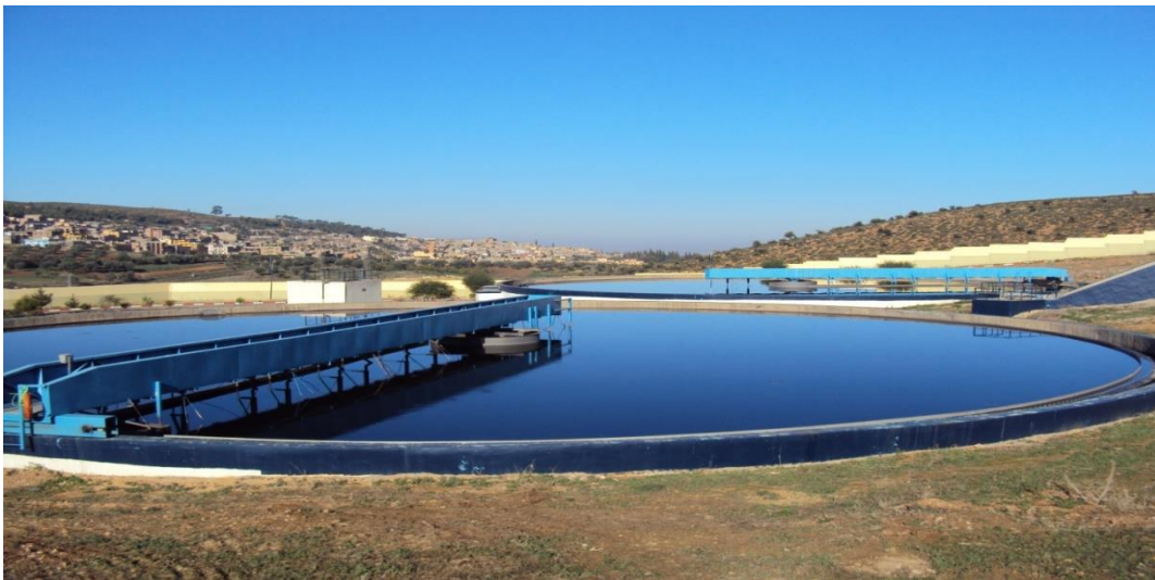
Figure IV. 11: Décanteur secondaire [53].
