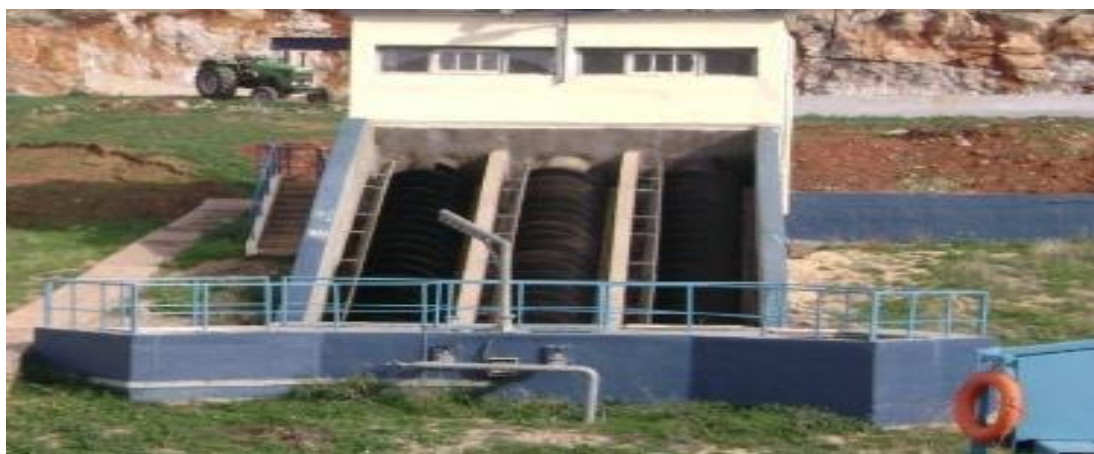
Figure IV. 13: Vis d'Archimède [53].
