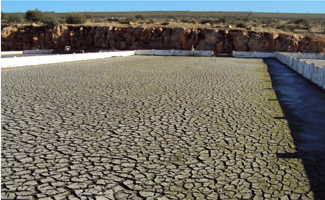
Figure IV. 15: Lit de séchage [53].
