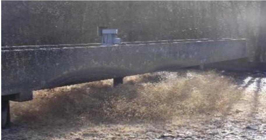
Figure II. 9: Aération de surface par turbine [39].
