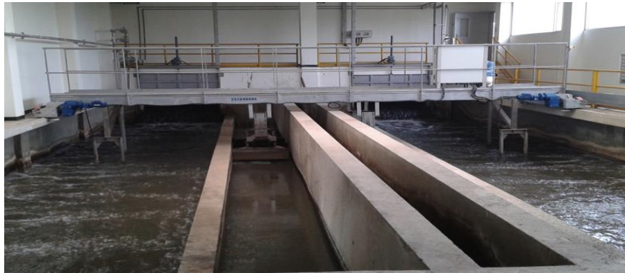
Figure II. 3: Déshuileur-dégraisseur [32].
