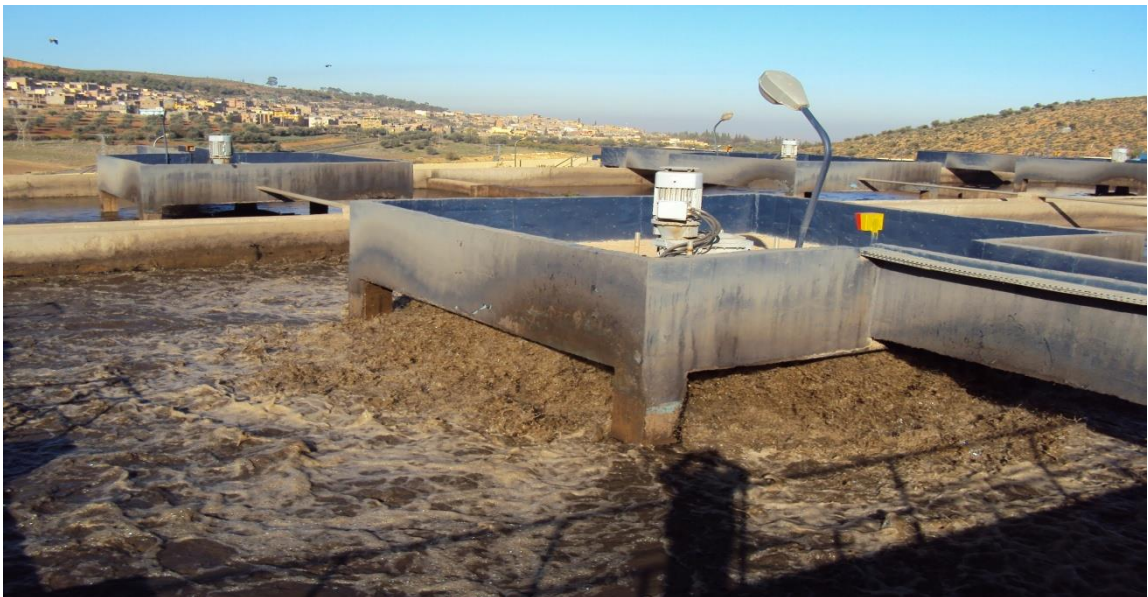
Figure IV. 8: Bassin d'aération [53].
