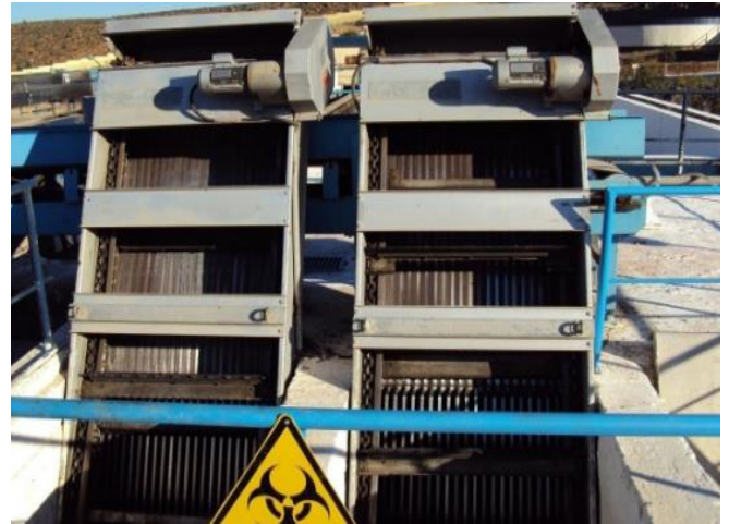
Figure IV. 4: Grille mécanisée [53].
