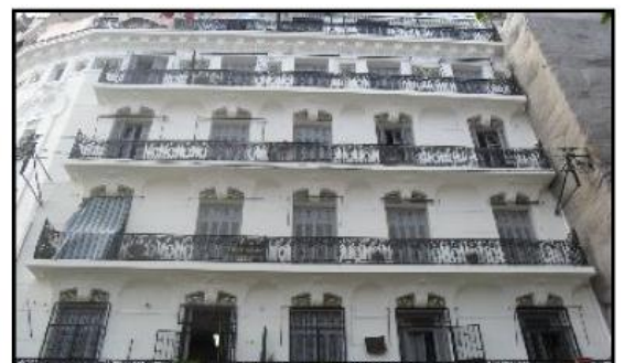
Figure 9 : immeuble 67 rue d'Isly à Alger après réhabilitation
