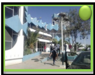
La nouvelle gare
