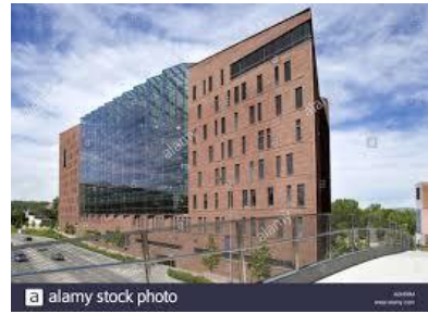
L'effet de contraste dans la façade entre l'ancien et le nouveau bâtiment.
