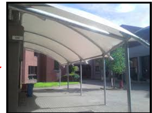
L'installation d'une toiture métallo textile pour les cours
