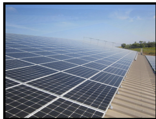
L'installation des panneaux solaires pour la toiture principale
