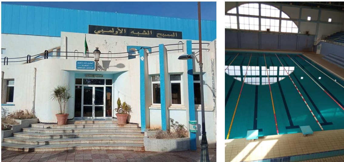
Figure 3 : Piscine semi olympique à Sebdo
