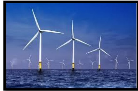
Figure 206station d'énergie éolienne Source : exploiteurs -énergie .com.
