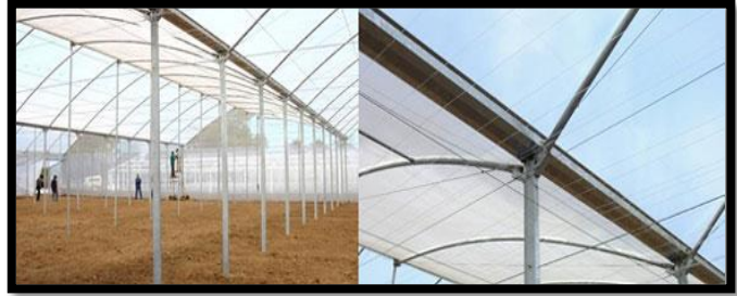
Figure 186 : la gouttière des serres, Source : https://www.invernaderosima.com/
