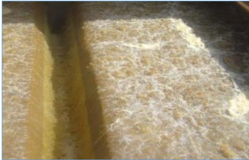
Figure 19 : Filière filtration à sable (Bentrar Ahlem, 2023).
