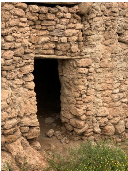
Figure III.45: Dispositif constructif d'une porte traditionnelle en bois. [48]
