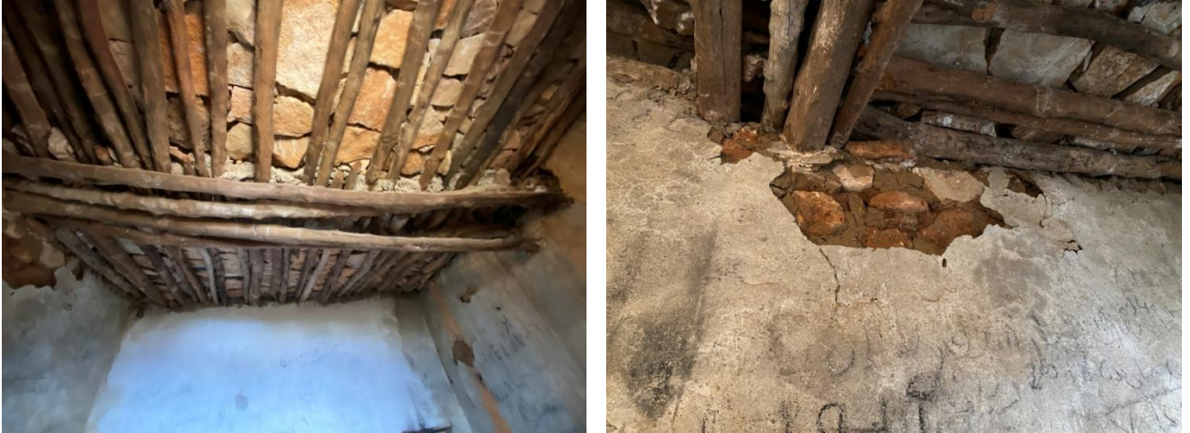
Figure III.25: Dispositif constructif d'un plancher traditionnel. [48]
