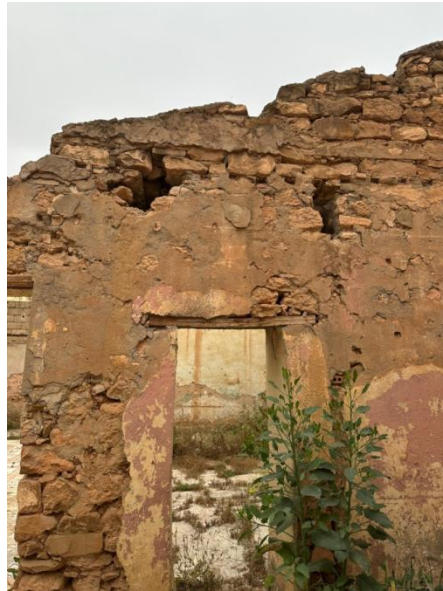
Figure III.44: Ouverture dans un mur ancien en maçonnerie, surmontée par un linteau en bois. [48]
