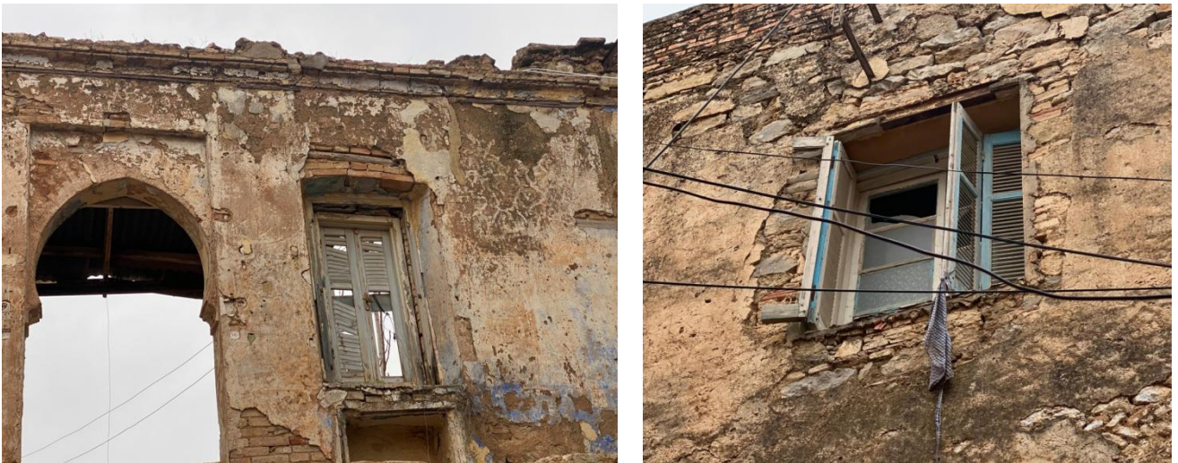
Figure III.27: Façade ancienne présentant des ouvertures. [48]
