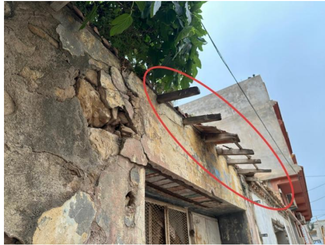
Figure III.23: Mur en maçonnerie avec extrémités de solives en bois apparentes. [48]
