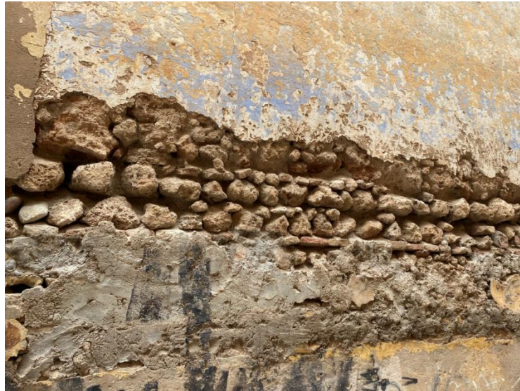
Figure III.3: Mur en maçonnerie de moellons à disposition irrégulière. [48]
