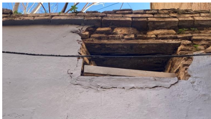
Figure III. 30: Petite ouverture en partie haute d'un mur en maçonnerie de pierre. [48]
