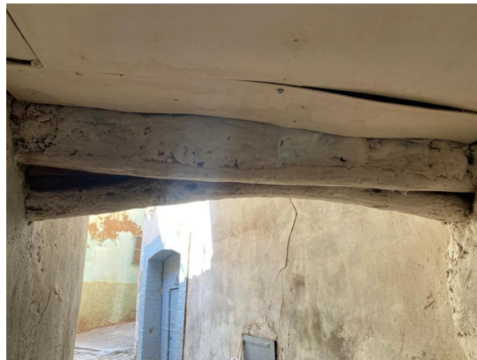
Figure III.20: Poutre principale en bois intégrée dans un plancher traditionnel, avec présence d'un faux plafond indiquant une intervention de réhabilitation.[48]
