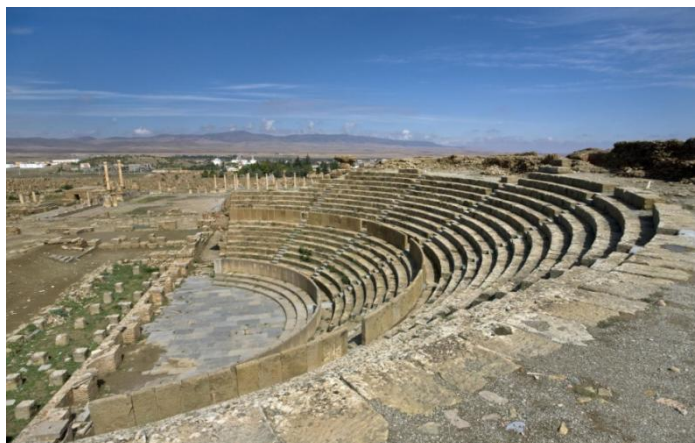
Figure I.7: Théâtre romain de Timgad (structure en pierre avec noyau interne en opus caementicium). [15]
