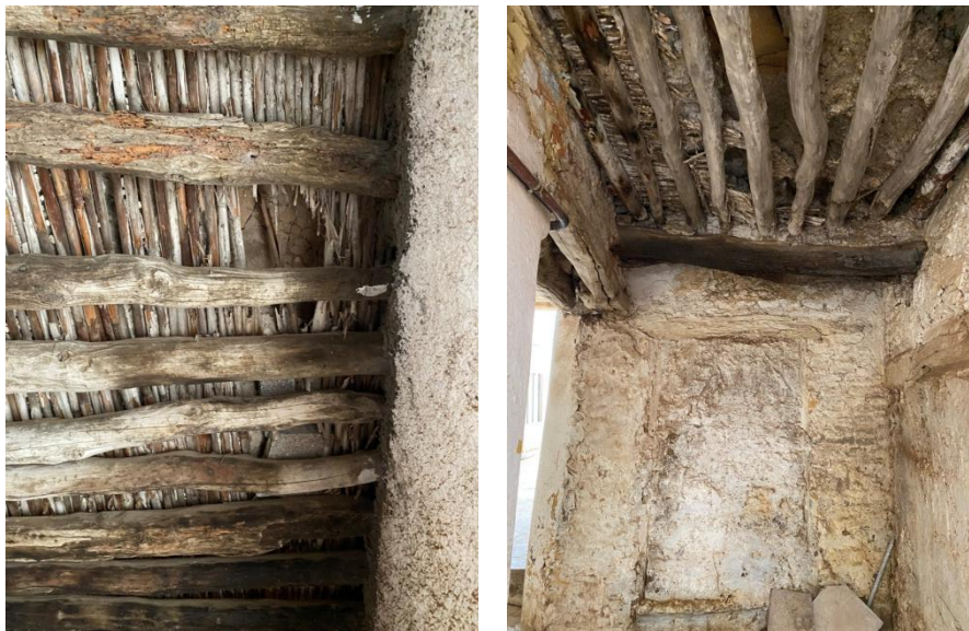
Figure III.18: Plancher traditionnel en bois.[48]
