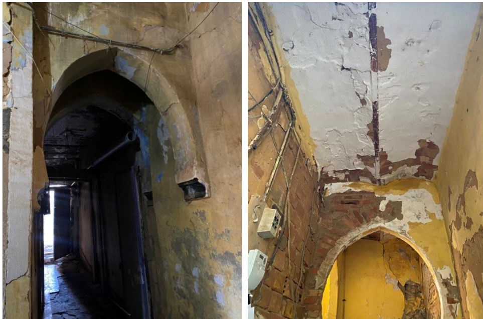
Figure III.48: Passage intérieur couvert par un arc en maçonnerie enduite. [48]
