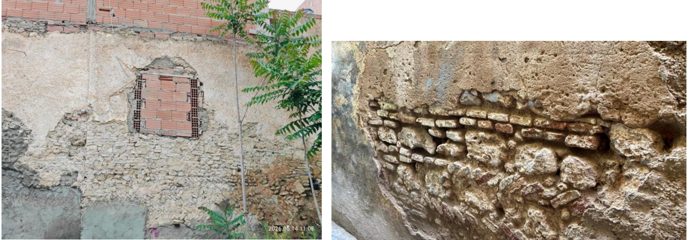
Figure III.10: Mur ancien en maçonnerie de pierre, composé de moellons et de pierre de taille. [48]
