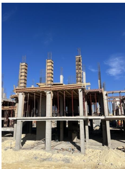
Figure I.25: Structure en béton armé (système poteaux-poutres) en cours de réalisation dans une construction moderne en Algérie. [48]
