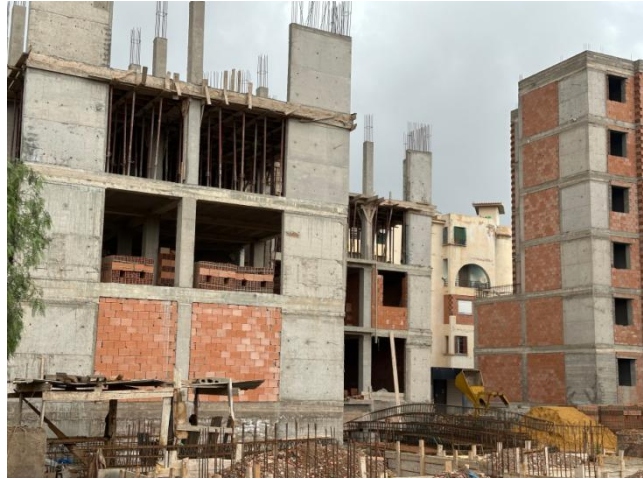
Figure I.26: Voiles en béton armé assurant la stabilité et la résistance aux efforts horizontaux dans une construction moderne à Tlemcen. [48]
