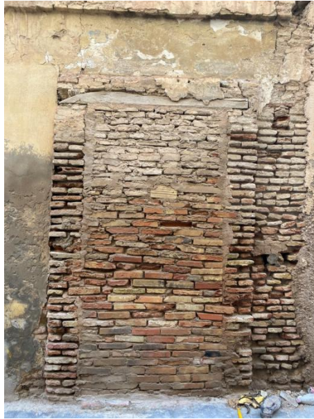
Figure III.40: Ancienne porte obturée dans un mur en pierre, avec linteau et encadrement marqué. [48]
