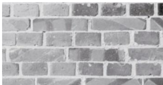
Figure II.5: Maçonnerie en brique pleines, années 1900. [39]
