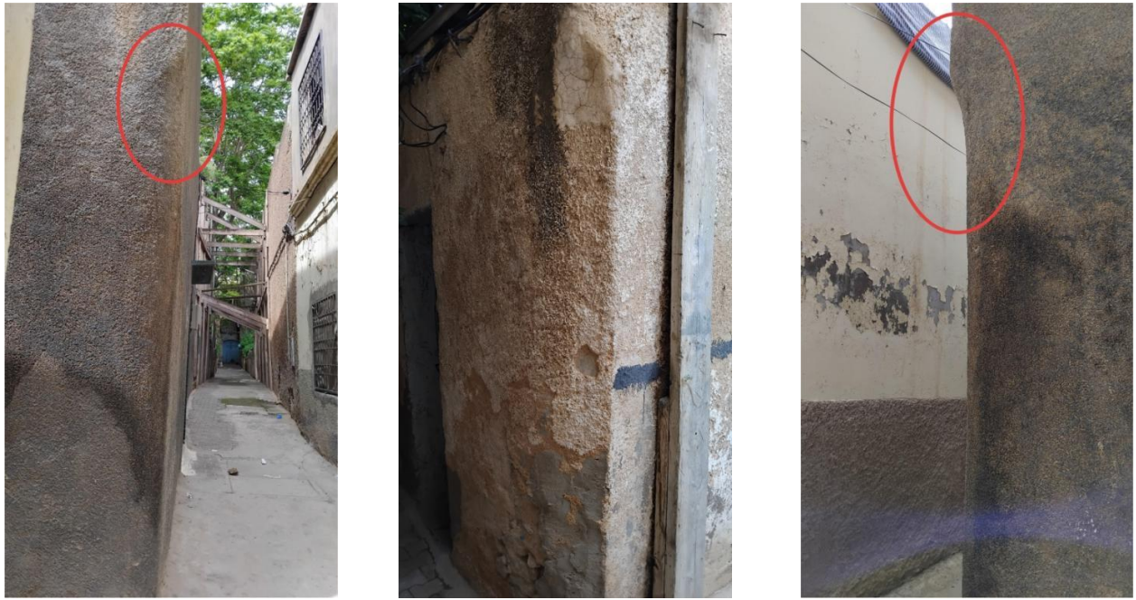
Figure III.51: Angle de bâti massif caractéristique de l'architecture ottomane (Rhiba, Tlemcen). [48]
