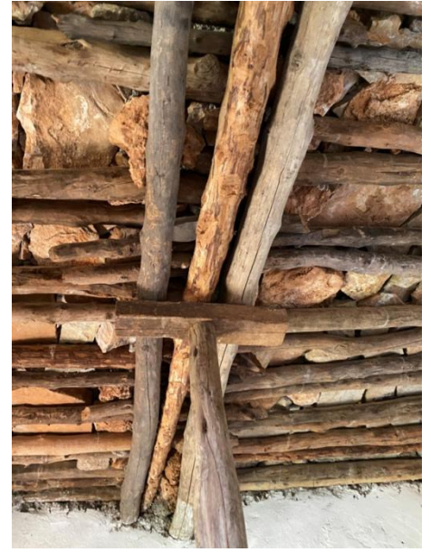
Figure III.24: Système de plancher traditionnel en bois avec poteau de soutien. [48]
