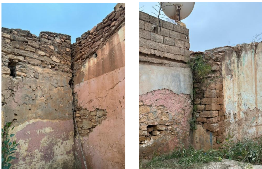
Figure III.11: Mur en maçonnerie de pierre. [48]
