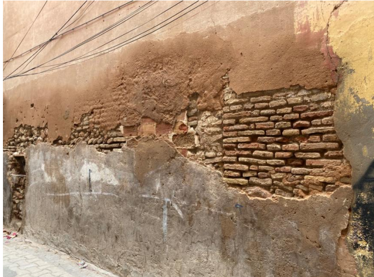
Figure III.4: Mur en maçonnerie mixte associant la pierre (moellons) et la brique. [48]
