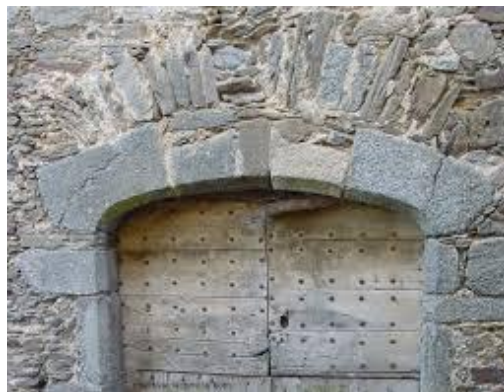
Figure II.16: exemples d'arc de décharge.[45]
