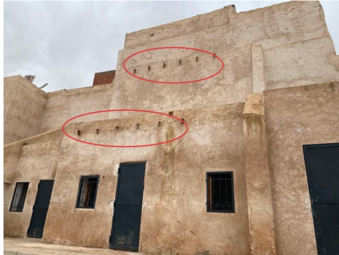
Figure III.17: Façade présentant des éléments métalliques apparents intégrés dans le mur. [48]
