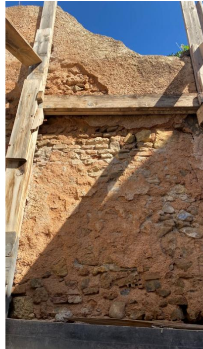
Figure III.6: Mur en maçonnerie de pierre associant des pierres de taille et des moellons disposés de manière irrégulière. [48]
