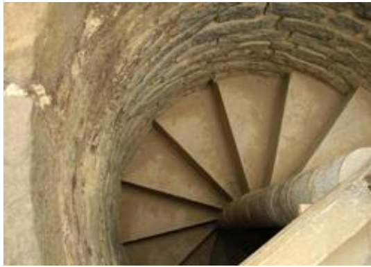
Figure II.21: escalier en vis en pierre. [39]
