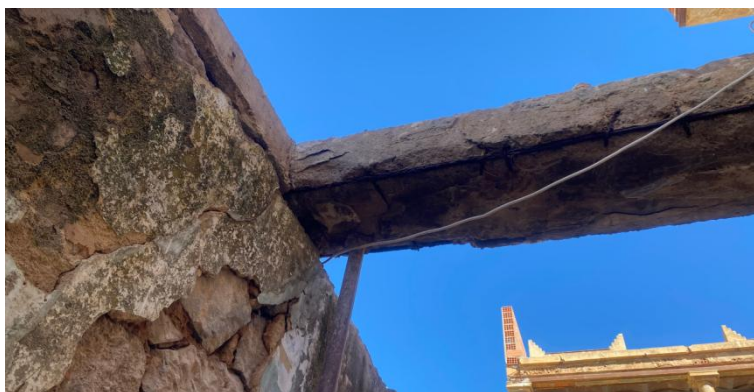
Illustrant un système constructif mixte à Tlemcen. (Auteure, 2026).
