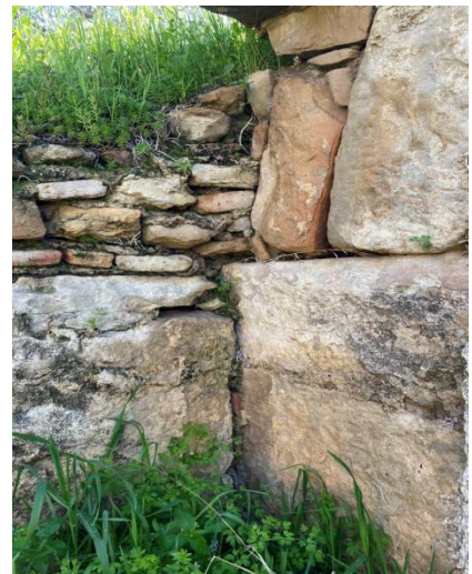
Figure III.5: Vestiges d'un mur en maçonnerie de pierre constitué de blocs de différentes dimensions (moellons et pierres de grande taille). [48]
