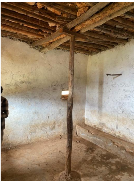
Figure III.24: Système de plancher traditionnel en bois avec poteau de soutien. [48]
