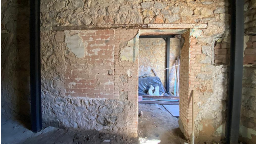
Figure III.38: Porte intérieure intégrée dans un mur en pierre, avec encadrement en pierres taillées. [48]
