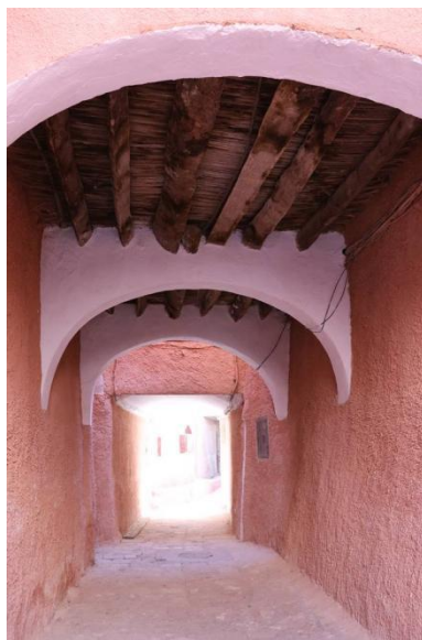
Figure I.15: Galerie couverte avec arcs et plancher en bois, illustrant les techniques constructives traditionnelles en terre. [22]
