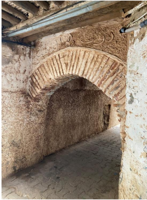
Figure III.47: Passage couvert en maçonnerie avec arc en pierre assurant la couverture. [48]
