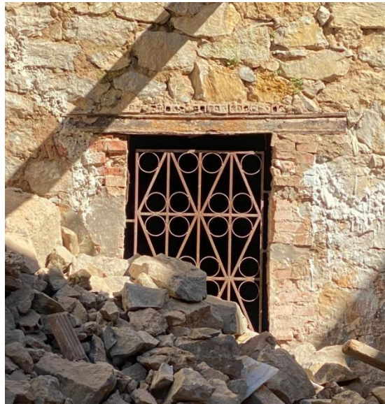
Figure III.29: Ouverture encadrée par des éléments en pierre avec présence d'un linteau métallique. [48]
