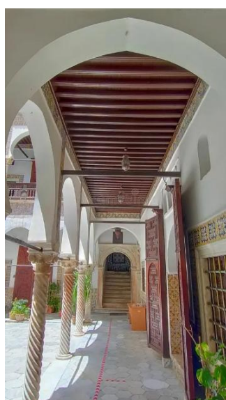
Figure I.19: Association d'arcs et de plancher en bois dans une galerie traditionnelle à casbah Algérie, assurant la répartition des charges dans l'architecture ottomane.
