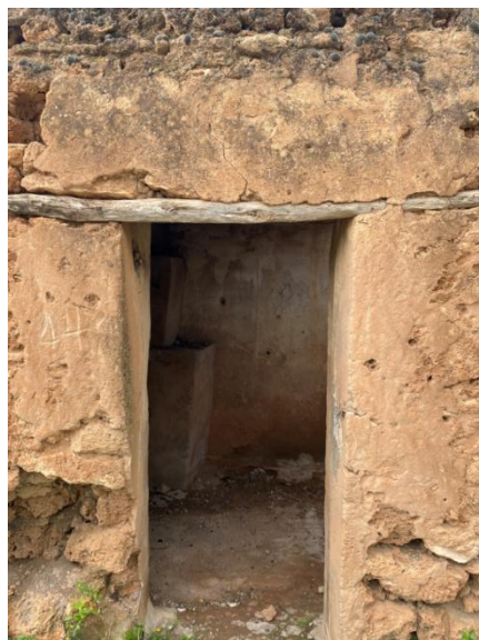
Figure III.45: Dispositif constructif d'une porte traditionnelle en bois. [48]
