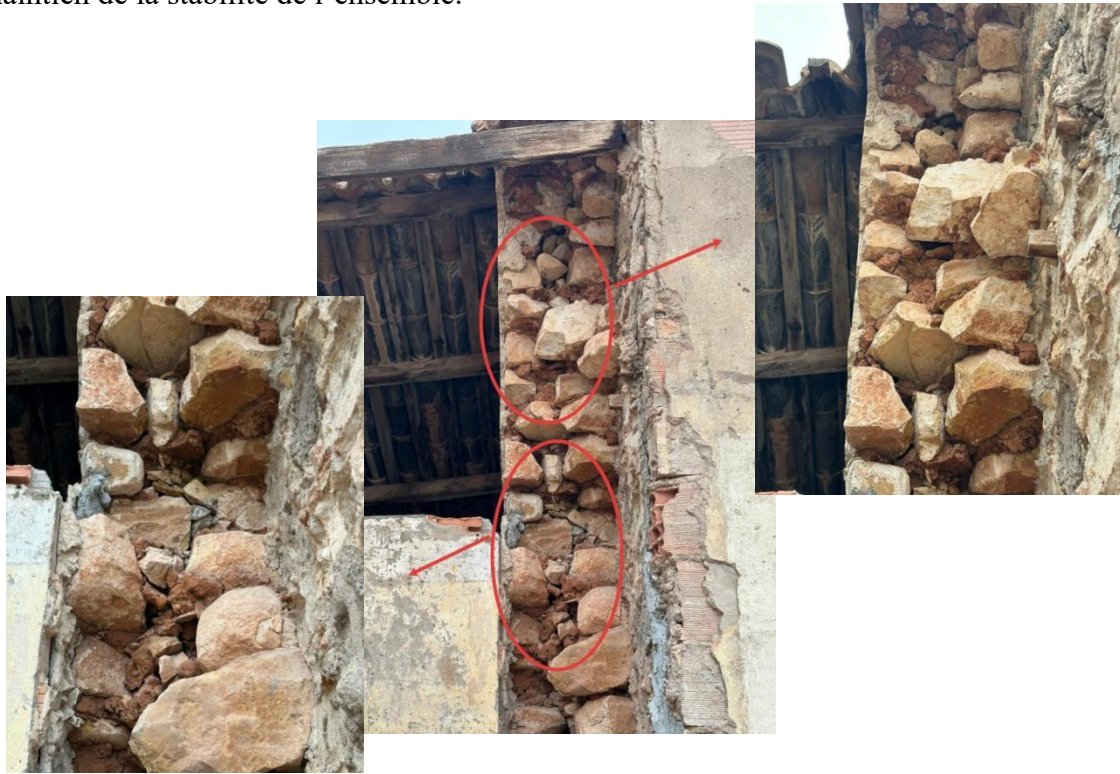
Figure III.12: Mur en maçonnerie de pierre présentant une grande épaisseur avec un remplissage intérieur en fourrure. [48]
