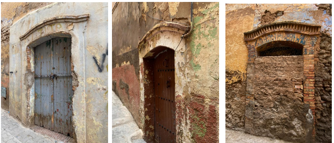
Figure III.37: Portes en arc plein cintre avec encadrement renforcé. [48]
