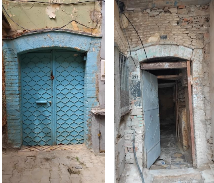
Figure III.42: Encadrement traditionnel des ouvertures par pierre taillée et arc de décharge. [48]
