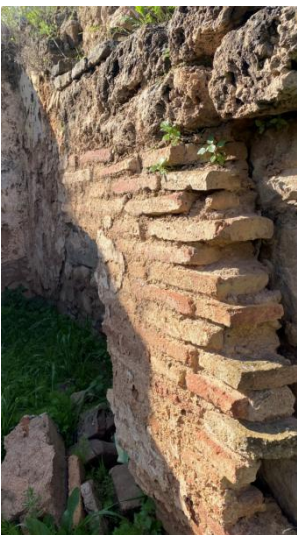
Figure III.5: Vestiges d'un mur en maçonnerie de pierre constitué de blocs de différentes dimensions (moellons et pierres de grande taille). [48]
