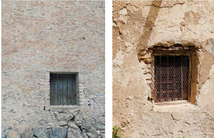
Figure III. 32: Détail d'une baie avec encadrement renforcé en pierre de taille. [48]
