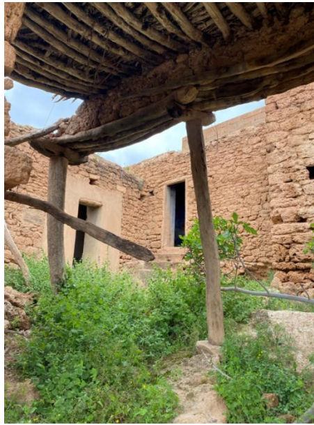
Figure III.24: Système de plancher traditionnel en bois avec poteau de soutien. [48]
