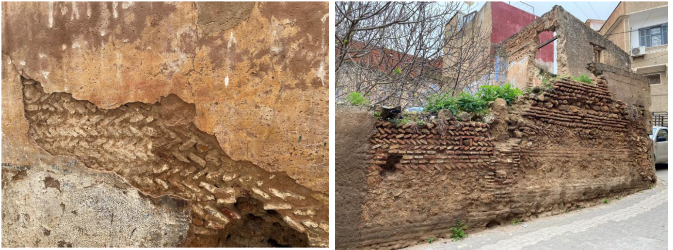
Figure III.2: Mur en maçonnerie de pierre de moellons. [48]
