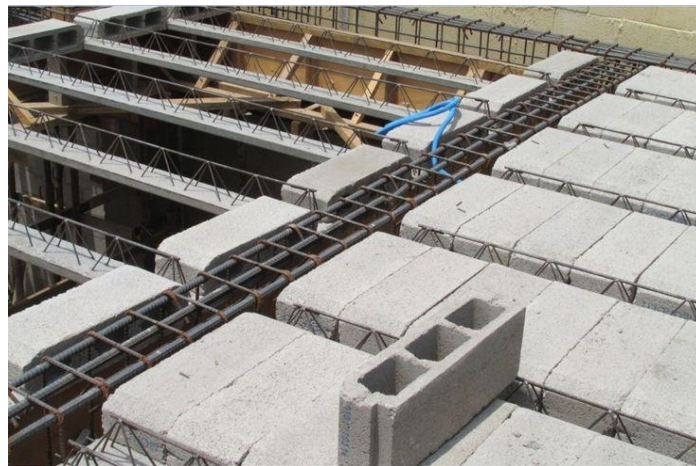
Figure I.27: Plancher en corps creux (hourdis) avec poutrelles et ferrailage dans une construction en béton armé. [36]
