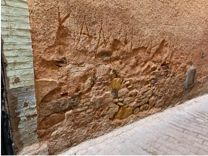
Figure III.6: Mur en maçonnerie de pierre associant des pierres de taille et des moellons disposés de manière irrégulière. [48]
