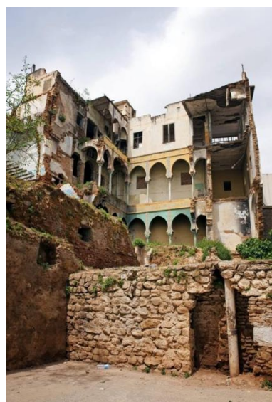
Figure I.17: Superposition des techniques constructives (pierre, arcs et structures légères) dans l'architecture traditionnelle ottomane en casbah Algérie.[28]
