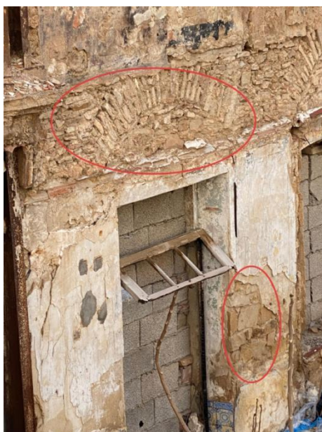
Figure III.39: Ouverture surmontée d'un arc de décharge en pierre avec traces de reprise en maçonnerie. [48]
