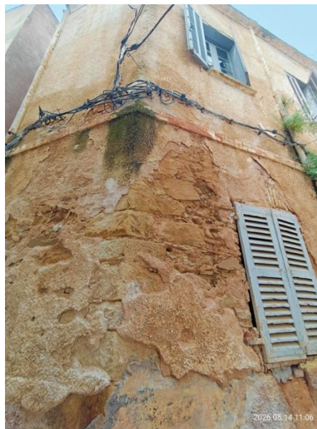
Figure III.9: Mur en maçonnerie de pierre présentant une liaison en harpe au niveau de l'angle assurant la continuité entre les deux murs. [48]
