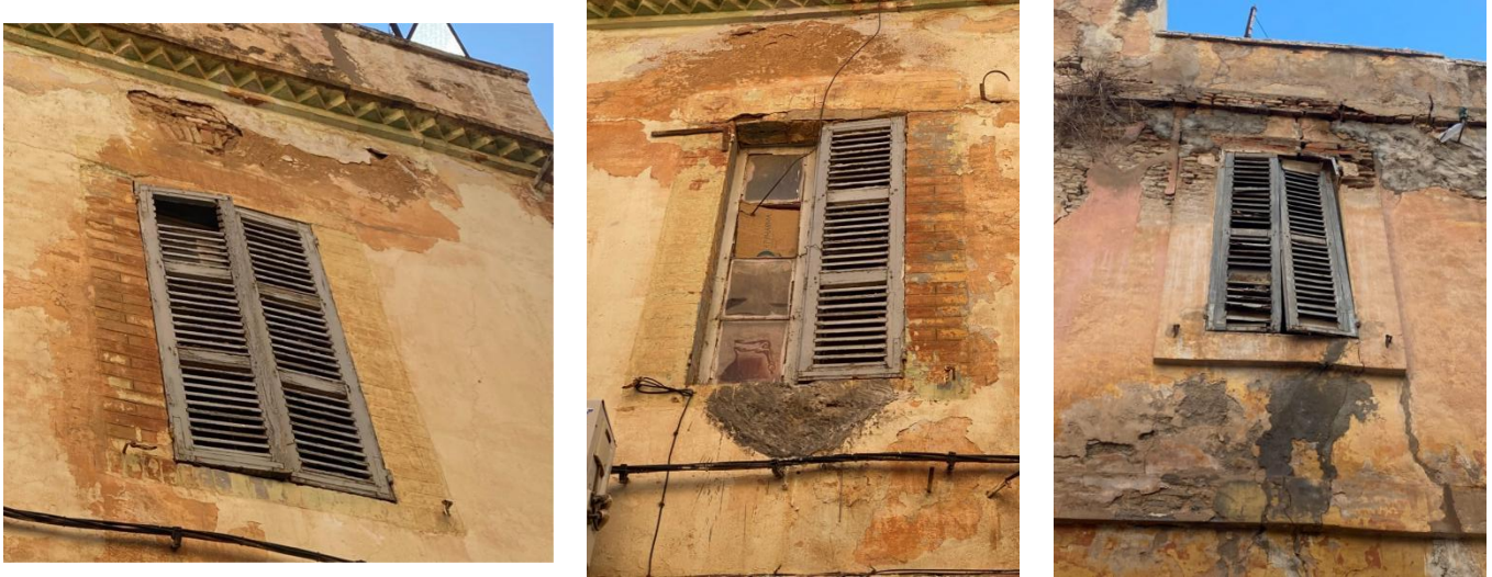
Figure III.30: Fenêtres intégrées dans une façade ancienne présentant différents dispositifs constructifs au niveau des ouvertures. [48]
