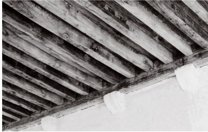
Figure II.11: Plancher à travure simple reposant sur des lambourdes appuyées sur corbeaux.[39]
