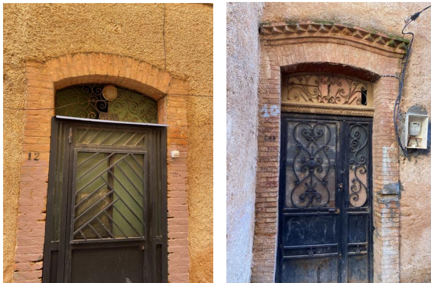
Figure III.41: Portes surmontées d'arcs en pierre, présentant des variantes décoratives et constructives. [48]
