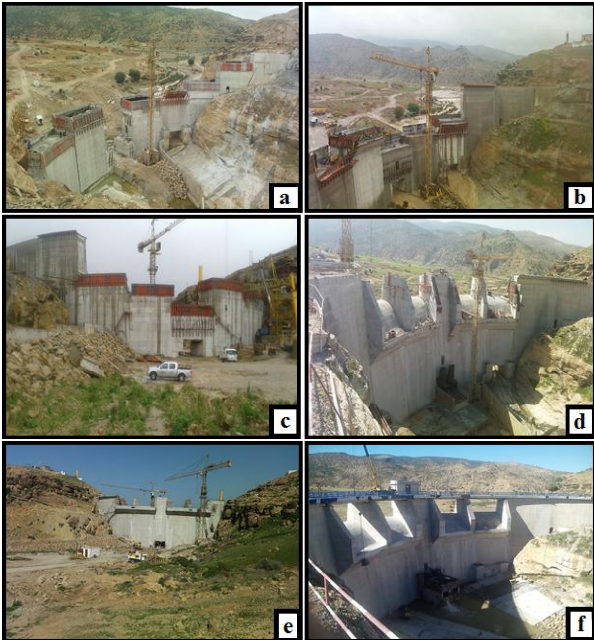
Photo VI.2 : Phase de réalisation du barrage.
