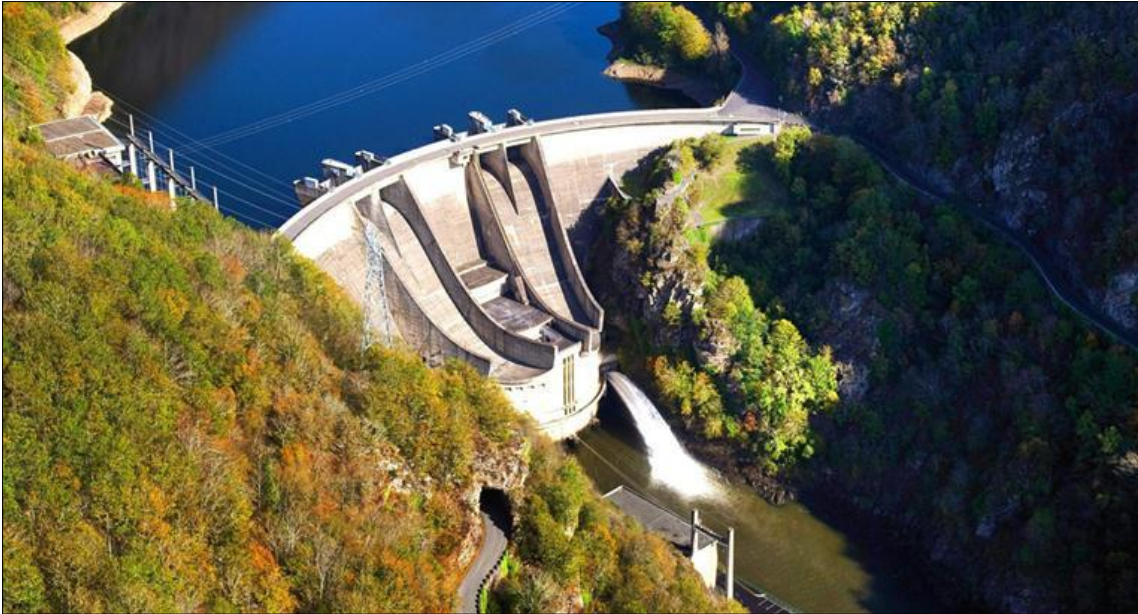
Photo I-3 : barrage poids voûte d'Aigle, France, 92 m.
