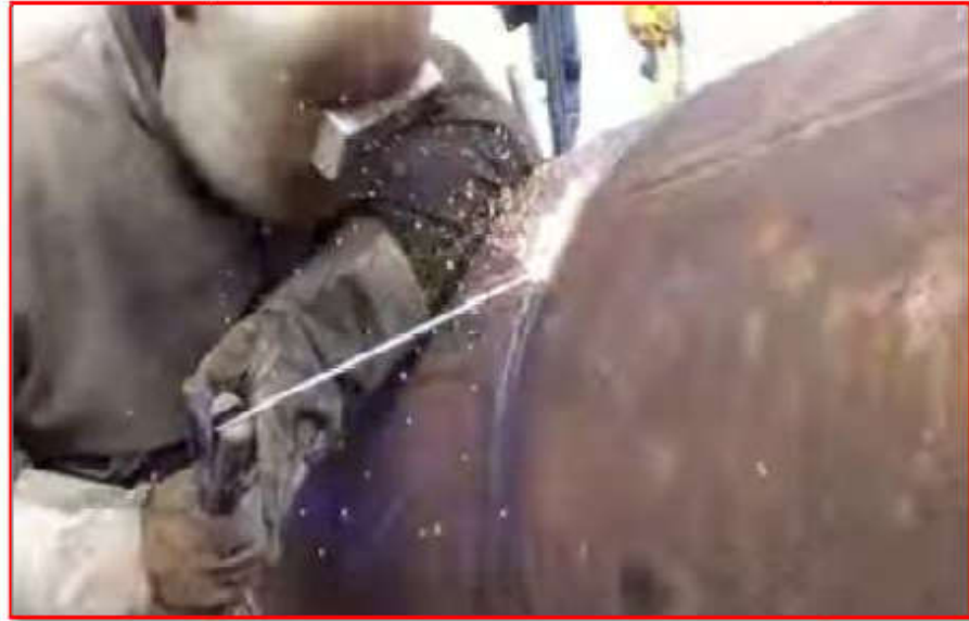
Figure.1 .3. Assemblage de deux tubes d'aciers API 5L X42 par le procédé de soudage à l'arc avec électrodes enrobées SMAW [15]
