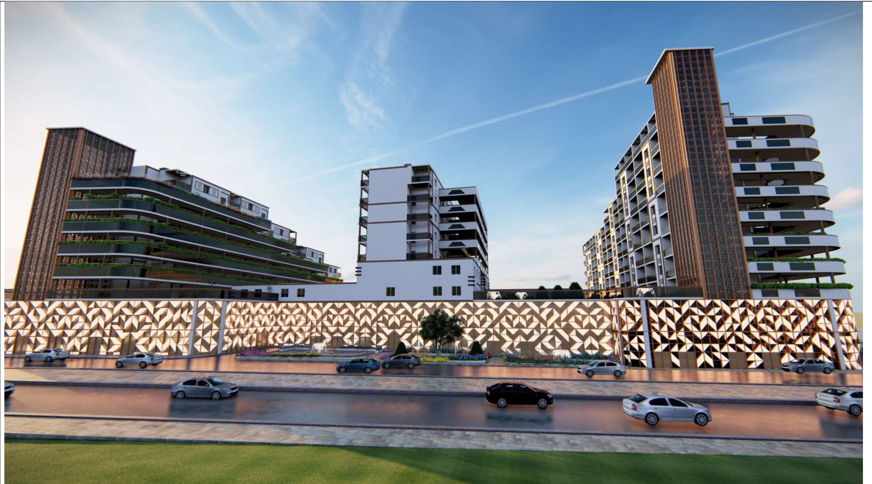
Figure 56. Vue depuis le parking extérieur et la façade 2 (source : mise en forme par l'auteur)
