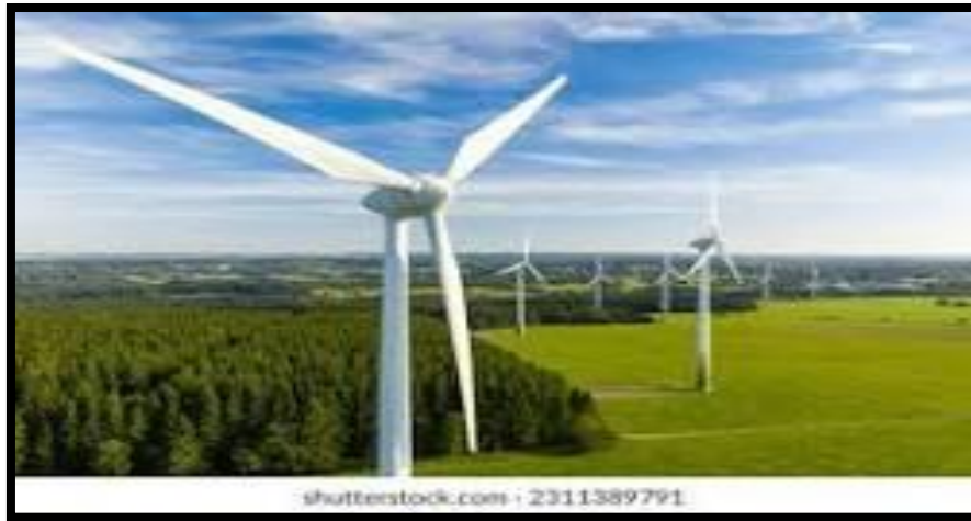
Figure 1.5 : Photographie d'un champ éolien [9]
