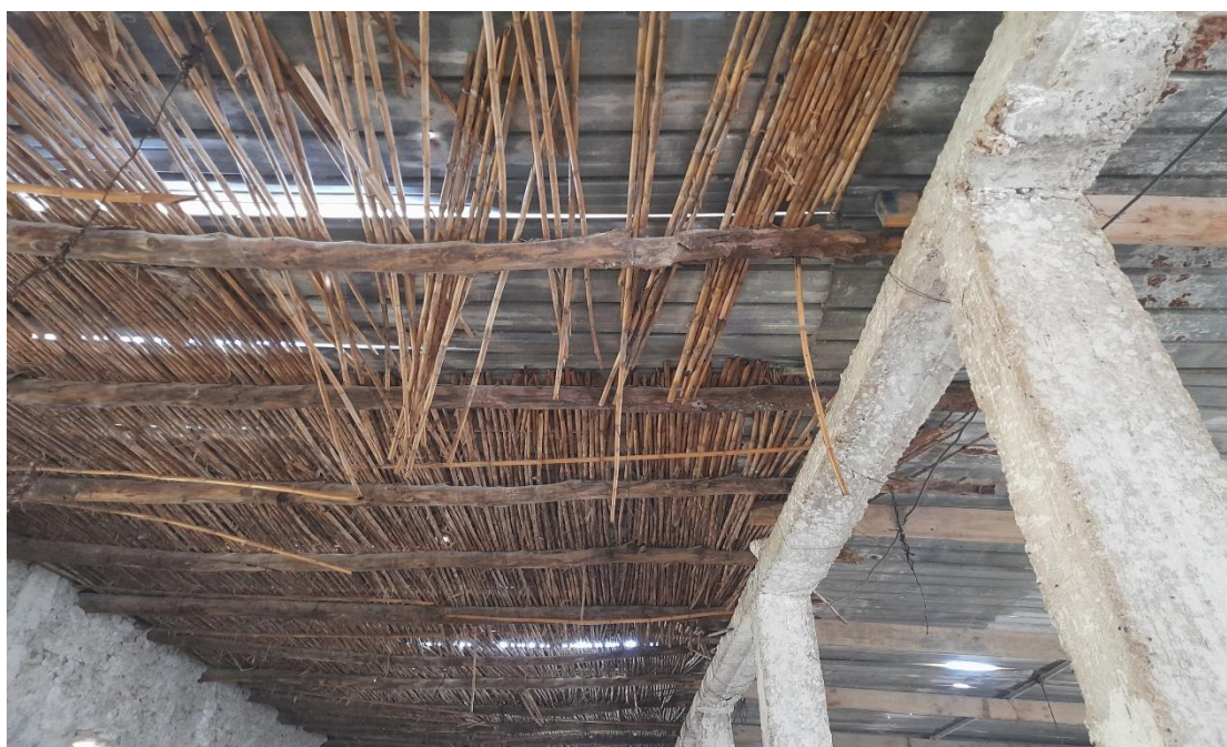
Figure 17 : b- Présence des trous dans le plafond ou toiture du bâtiment. (Photo Originale)
