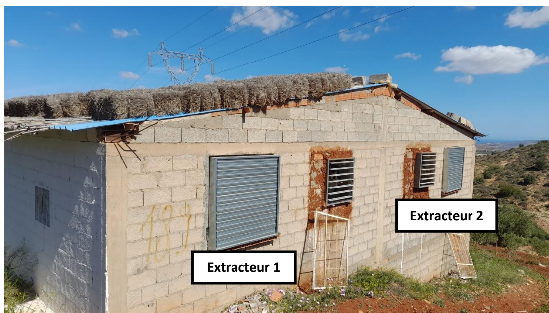
Figure 12 : Bâtiment d'élevage de poulets de chair (système intensif) (Photo Originale).
