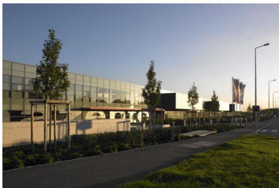
Figure 68 :centre de rééducation rehazenter Source www.archdaily.com
