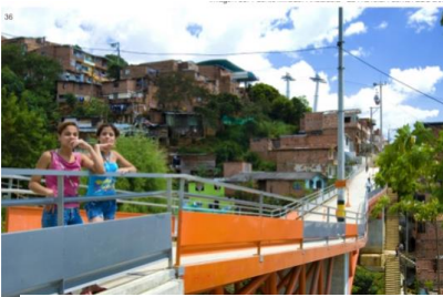
Figure 8 Le pont mirador "La Francia"
