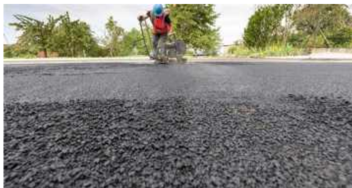
Figure n°4 : Béton bitumineux 0/14 dans son état de mise en place.
