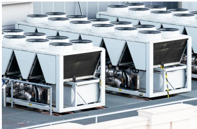
Figure 116. Système d'eau glacé
