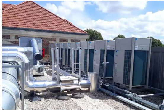
Figure 114. Unité extérieure de système de climatisation VRV
