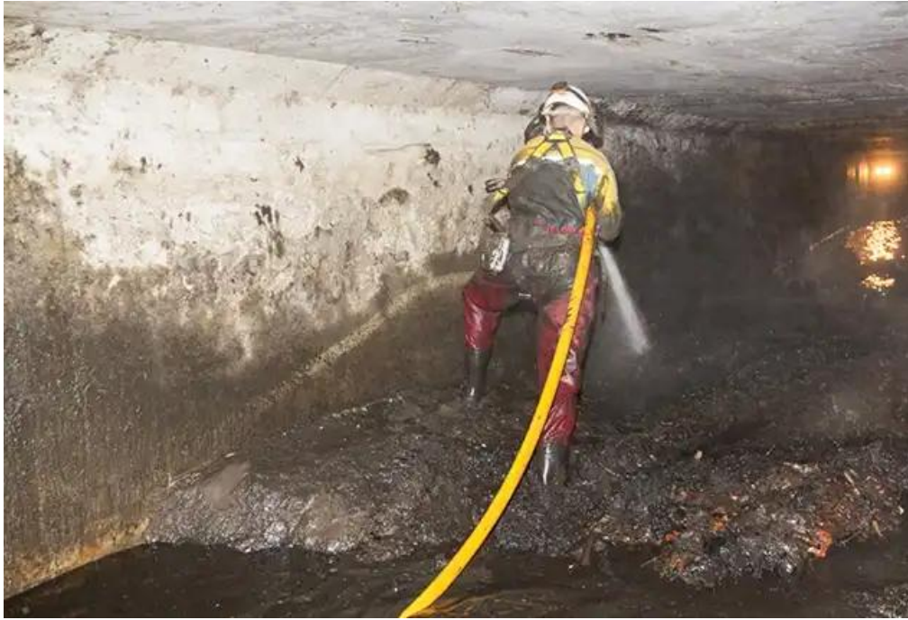
Figure 4. 4 - ouvrier dans un ouvrage en train de nettoyer au jet
