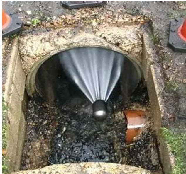
Figure 4. 3 - Nettoyage hydraulique d'un ouvrage d'assainissement par buse à jet haute pression.
