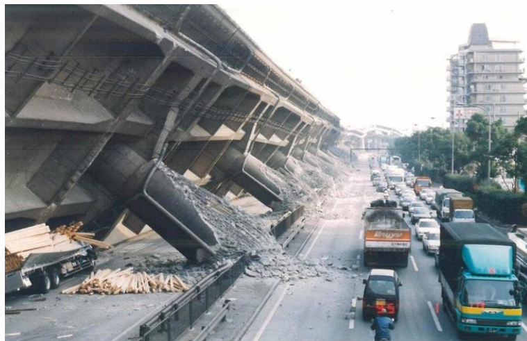
Figure 16. Effondrement du pont Fukae après le tremblement de terre de Kobe 1995
