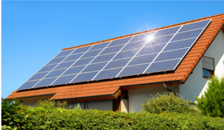
Figure 1.2 – Panneaux photovoltaïques pour la récupération de l'énergie solaire [1].
