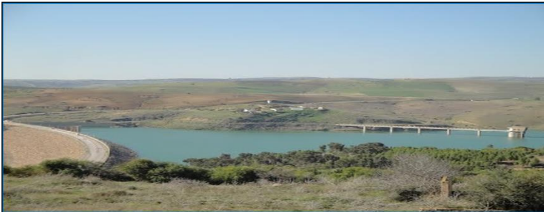
Photo 1 : Barrage d'EL IZDIHAR le 13/09/2025 (Saouli ;2025)
