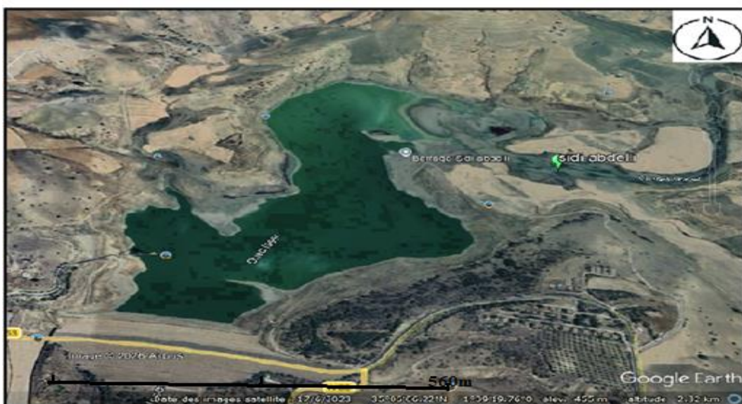
Photo 2 : Image satellitaire du barrage El Izdihar le 02/03/2026 (Saouli ;2026)
