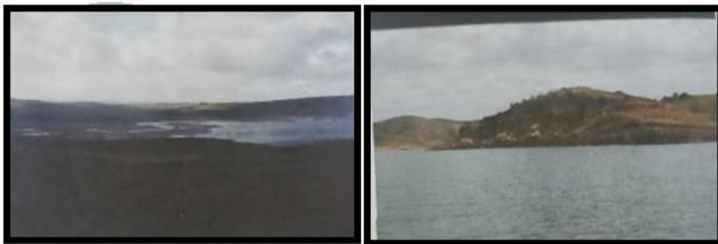
Photo 8 : Vues du réservoir du barrage de Sid Abdelli : érosion des berges et sédimentation lors du levé bathymétrique de 2019.
