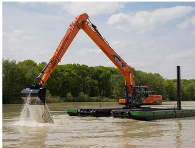
Photo 10 : Techniques de dévasement
