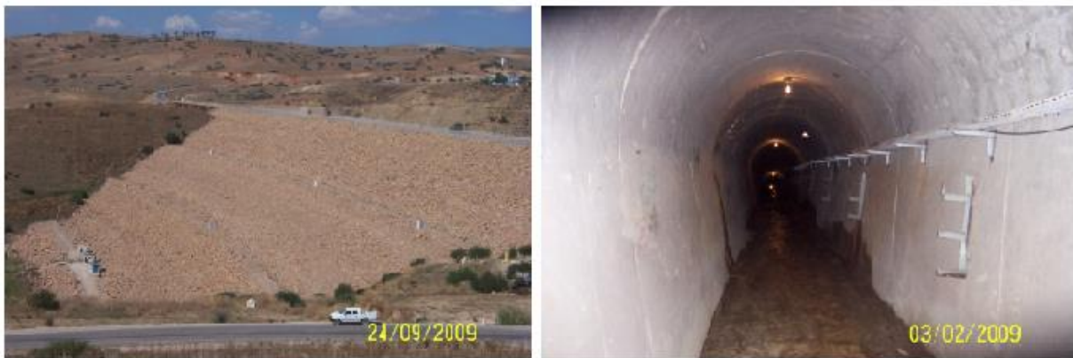
Photo 3 : Digue et galerie du barrage d'El Izdihar-Tlemcen
