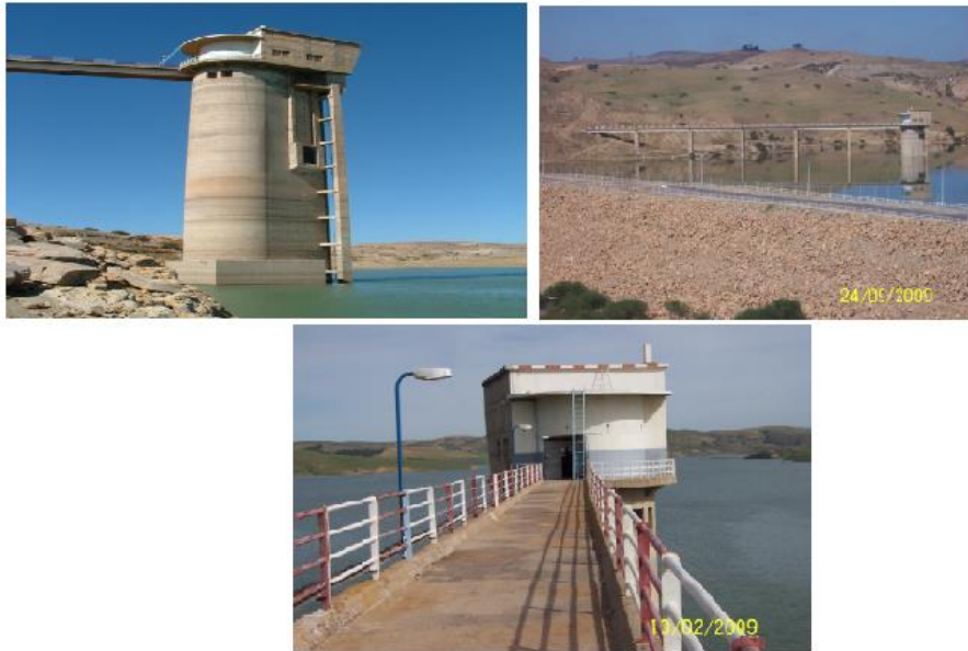
Photo 4 : Tour de prise d'eau du barrage
