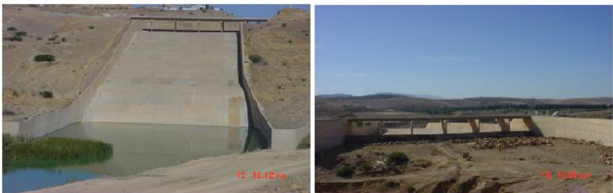
Photo 5 : Evacuateur de crue
