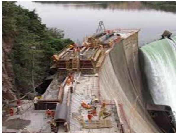
Photo 14 : Surélévation de l'ouvrage
