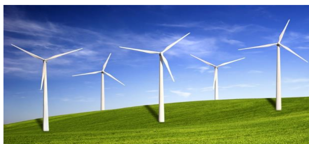
Figure23 : Des panneaux éolienne Source( https://lenergeek.com/2016/03/24/lassemblee-nationale-favorise-lenergie-eolienne/ )
