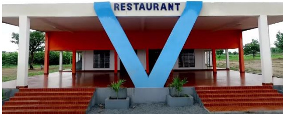
Figure48 : Façade du bloc de restauration. Source
