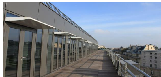
Figure13 : Etagère de lumière sur des porte fenêtres
