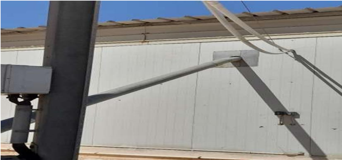
Figure I-11 Les vices qui transportent l'aliment des silos vers les trémies de chariot de distribution
