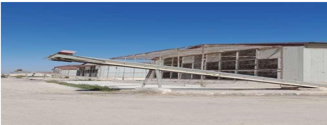
Figure I-18 Tapis d'évacuation des fientes Tapis d'évacuation des fientes
