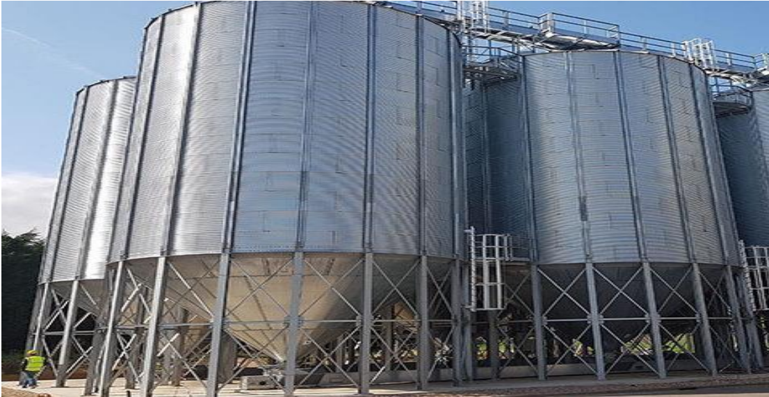
Figure II-29 Silos verticaux de stockage des matières premières (céréales)
