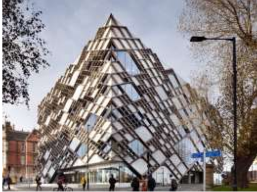
Figure 45:Façade non structurale
