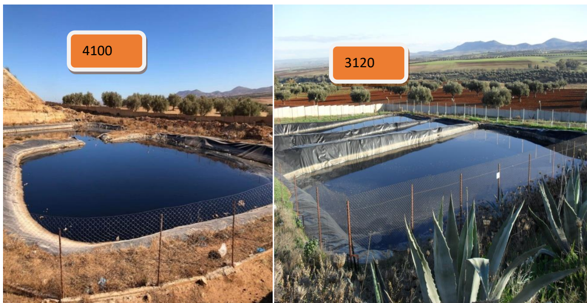
Figure 16 Bassin de récupération de lixiviat au niveau du 1er et 2eme casiers
