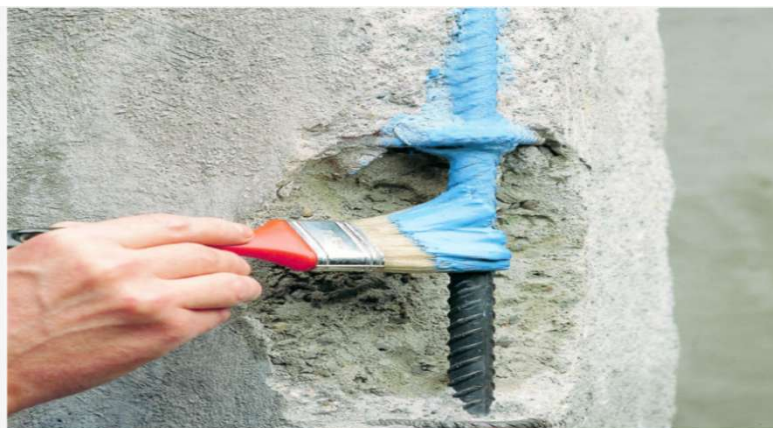
Figure 1.3 : Application d'un revêtement non métallique [4].
