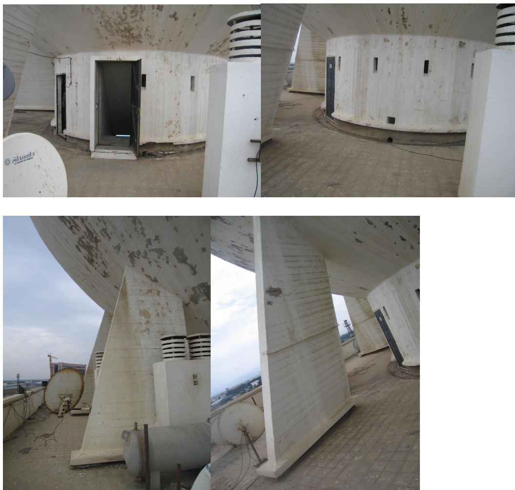
Figure 4.15 : Aspect de la structure supportant le château d'eau en terrasse
