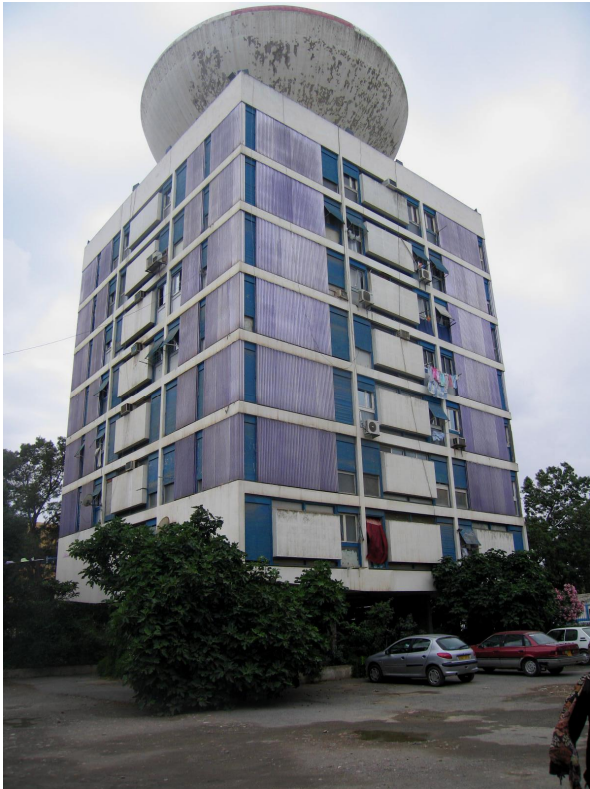
Figure 4.13 : Immeuble avec château d'eau en terrasse à Dar El Baïda, Alger datant de la période coloniale
