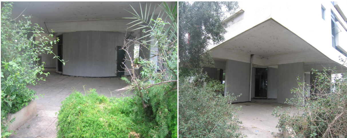
Figure 4.14 : Rez-de-chaussée libre avec accès à partir du noyau, structure apparente en voiles et plancher en dalle pleine, permettant un encorbellement de environ 3m.
