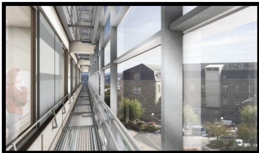
Photo 50:Façades double peaux
