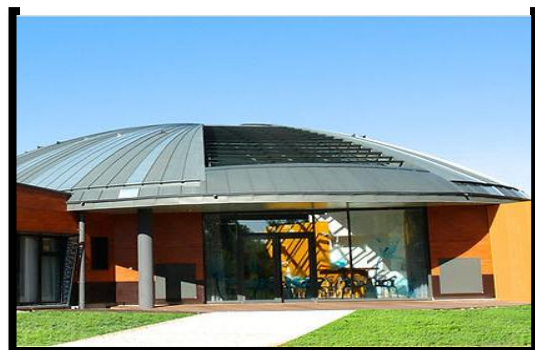
Photo 32:photo :la couverture en zinc
