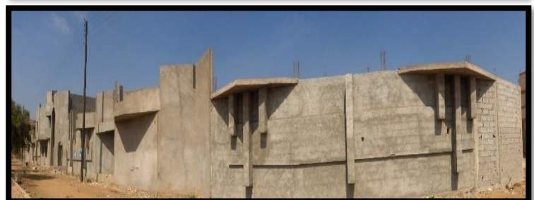
Photo 14: chantier source : Architect du projet
