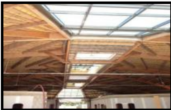
Photo 31:La structure de toits
