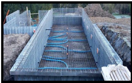
Photo 41:radier général pour piscine
