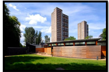
Photo 36: enveloppe du bâti en bois
