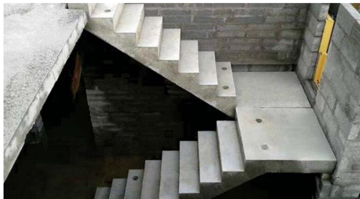
Figure 64: cage d'escaliers préfabriquée Source : https://www.pavebeton.fr/escalier-en-beton/
