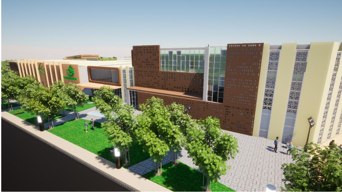
Planche 11 : Vue façade sud
