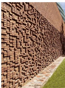
Figure 135 : Traitement en brique
