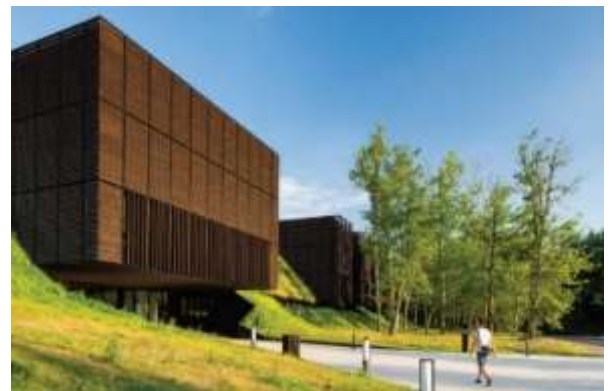
Figure 21: Centre de formation des apprentis.
