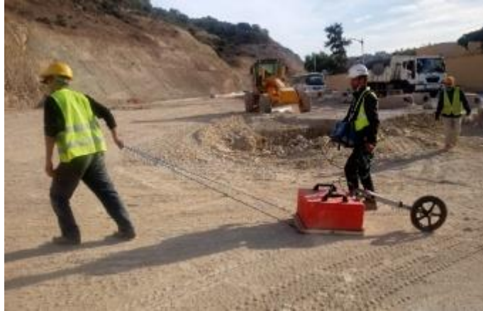
Photo 2. 7 : Photographie de l'investigation par géo-radar [15]
