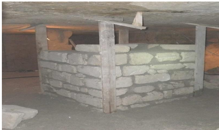
Figure 1. 24 : Construction d'un pilier maçonné [8]
