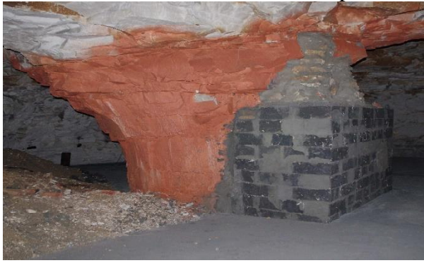
Figure 1. 22 : Reprise d'un pilier par maçonnerie [8] Figure 1. 23 : Cerclage-ceinturage d'un pilier [8]
