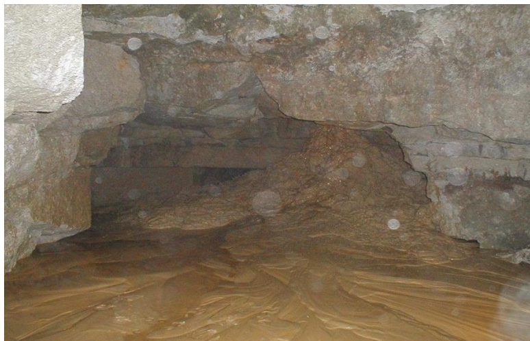
Figure 1. 26 : Comblement par coulis de silicates [8]
