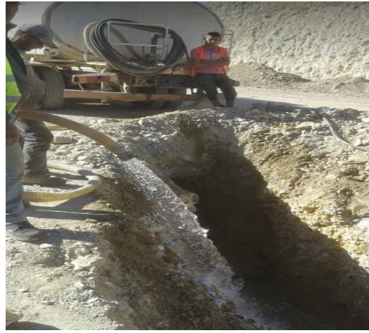
travaux d'inspection de volume et continuité des cavités
