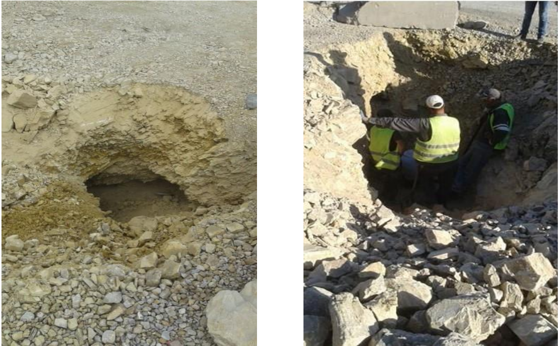
Photo 2. 5 : Photographies de la cavité détectée près de GIR2 prévue [15]
