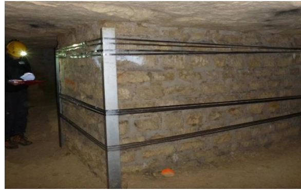
Figure 1. 22 : Reprise d'un pilier par maçonnerie [8] Figure 1. 23 : Cerclage-ceinturage d'un pilier [8]
