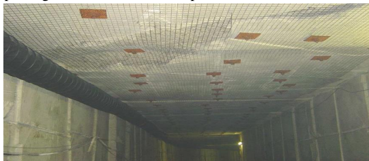
Figure 1. 21 : Boulonnage du toit d'une galerie [8]
