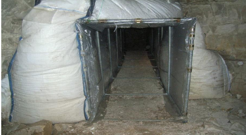
Figure 1. 27 : Tunnel édifié à travers la mousse expansive pour maintenir un passage [8]
