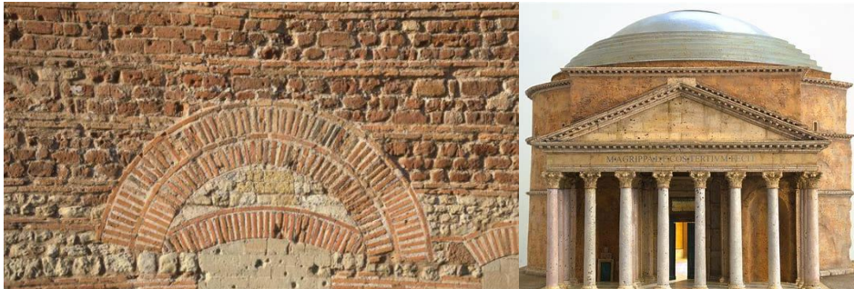
Figure 13: l'usage des briques dans l'usage des briques,
