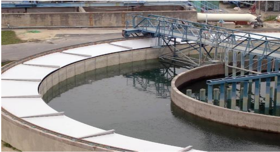
Figure 11: Décanteur primaire [26]
