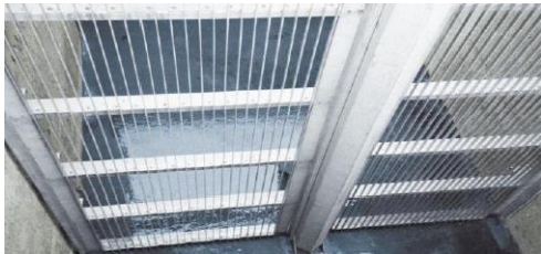
Figure 6 : Dégrillage grossier [21]
