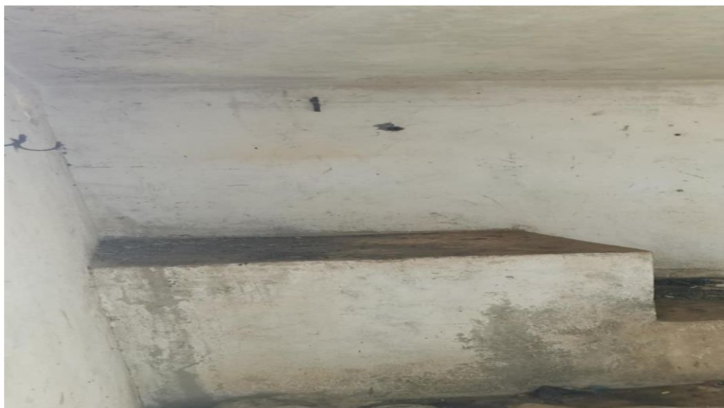
Figure 27: Station d'épuration de l'hôpital de Tlemcen
