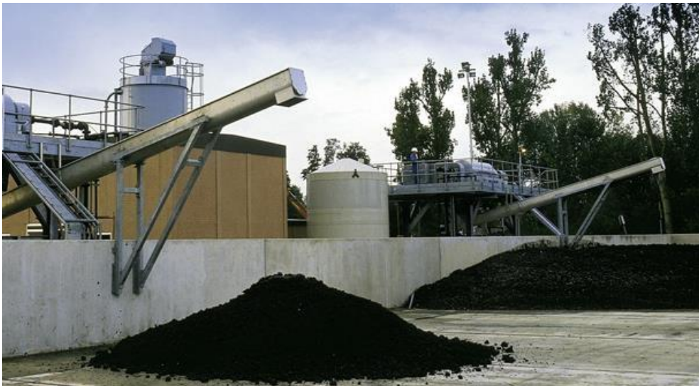
Figure 24: Epaississement et déshydratation des boues [38]
