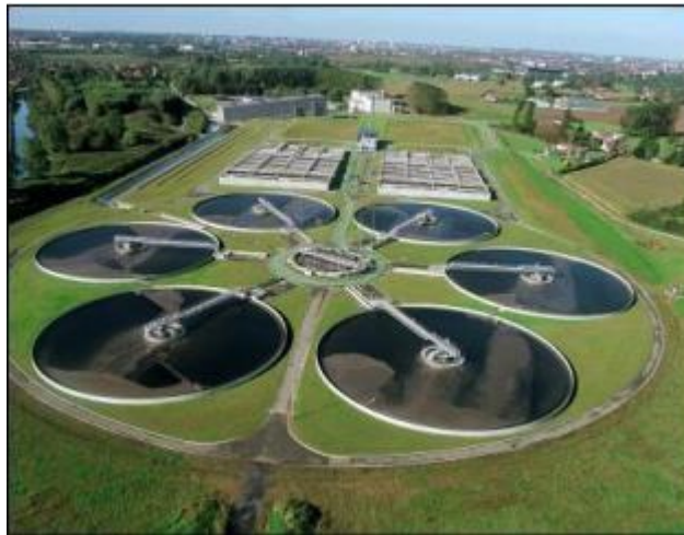
Figure 1: Vue aérienne d'une station d'épuration [3]
